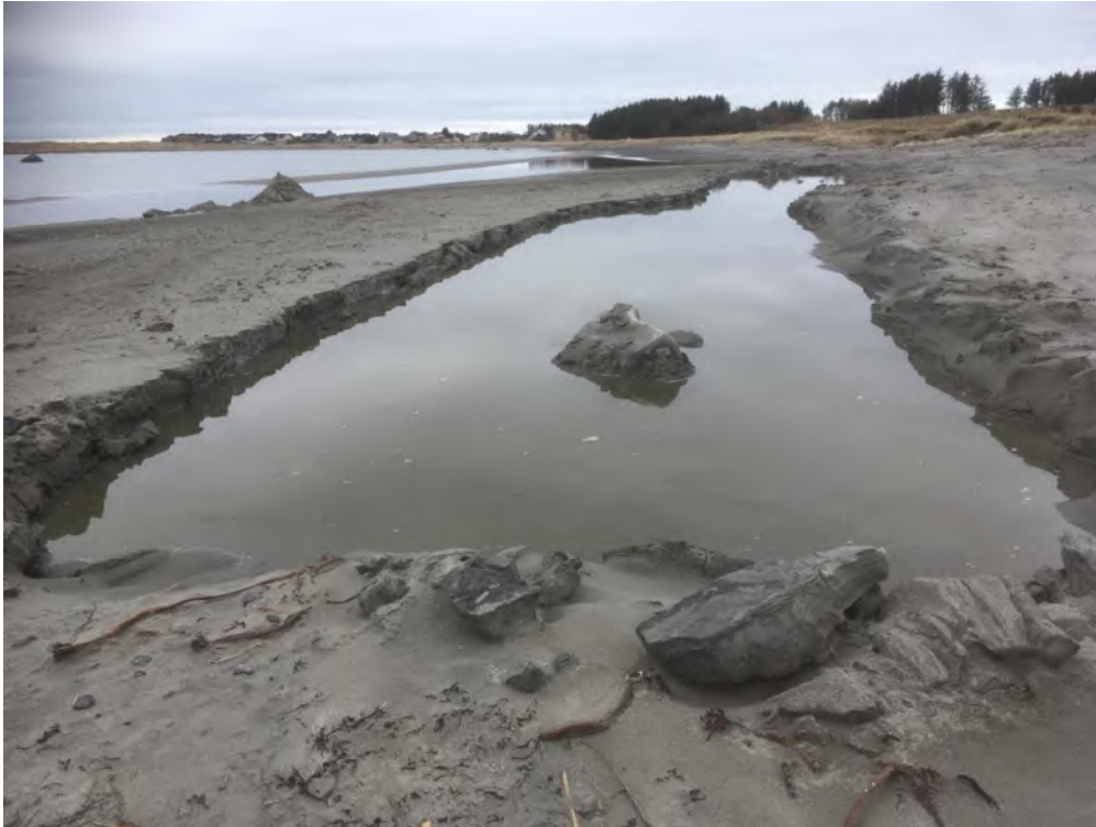
Fig. 13. Massetak på strandbredden midt på Nordhasselstranda. Uttaket av sand til jordforbedring på dyrka mark. Foto 12.mars. 2018. I juni var fortsatt deler av massetaket synlig, mens det etter høststormene i september/oktober 2018 var helt utjevnet av bølgenes arbeid. Foto: SNO
