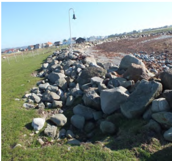
Fig. 15. Erosjonsvern i Vågsvollvika
