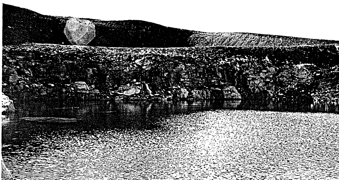
Fig. 15. Vannfylt steinbrudd ved Falningsjøen. Ved å drenere taket kan driften gjenopptas med tanke på produksjon av slitelagsgrus.
