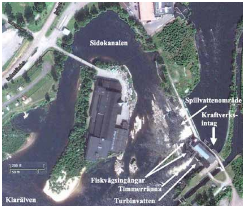
Figur 2. Flygfoto över Forshaga kraftverk med centrala delar utmärkta (bildkälla: Google Earth)
