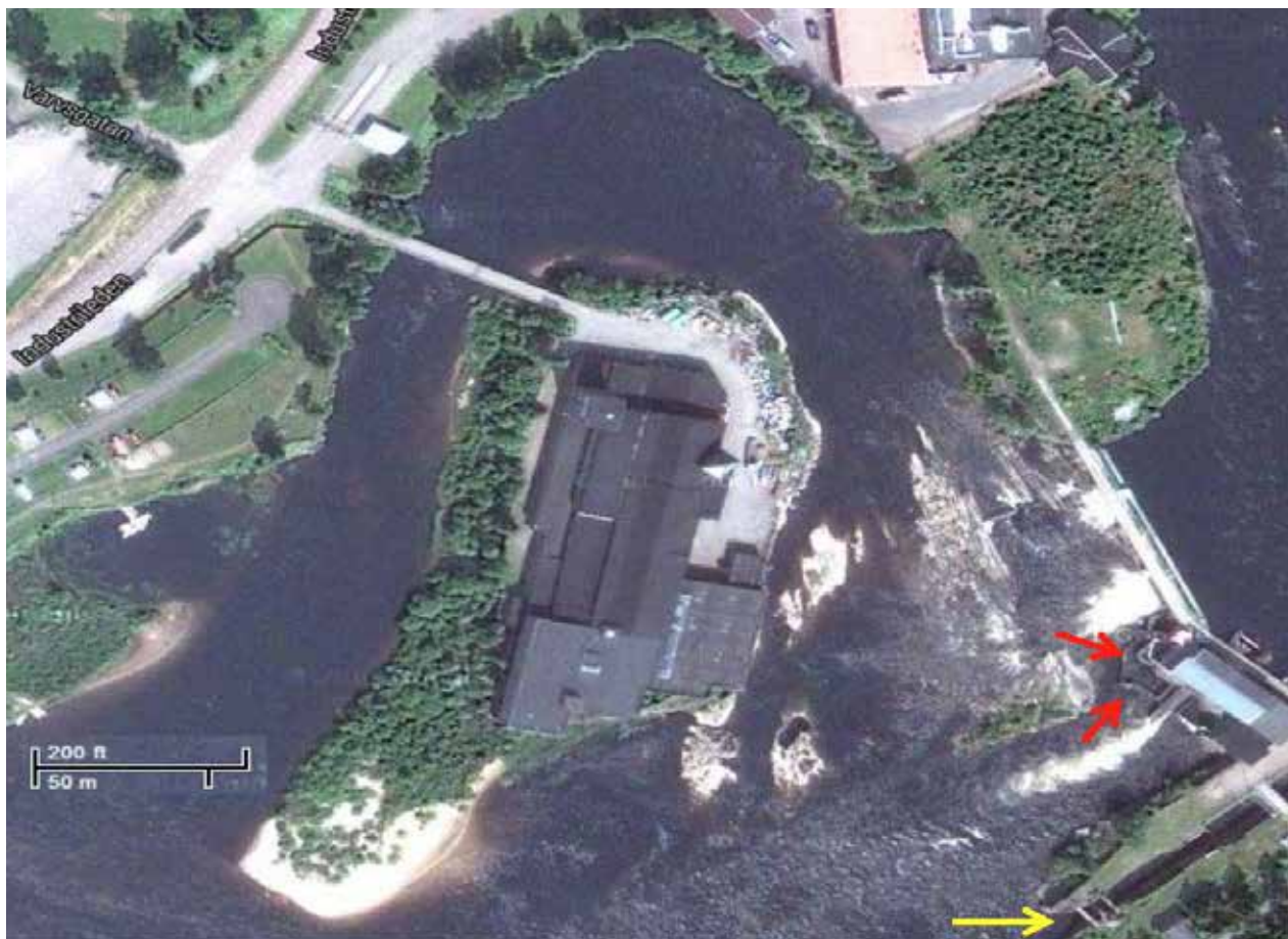
Figur 1. Oversiktsbilde over Forshaga kraftstasjon. Røde piler angir plassering påeksisterende fiskeinnganger til fisketrappa. Gul pil angir passasje-kanalsom foreslås ombygd til fiskepassasje.
