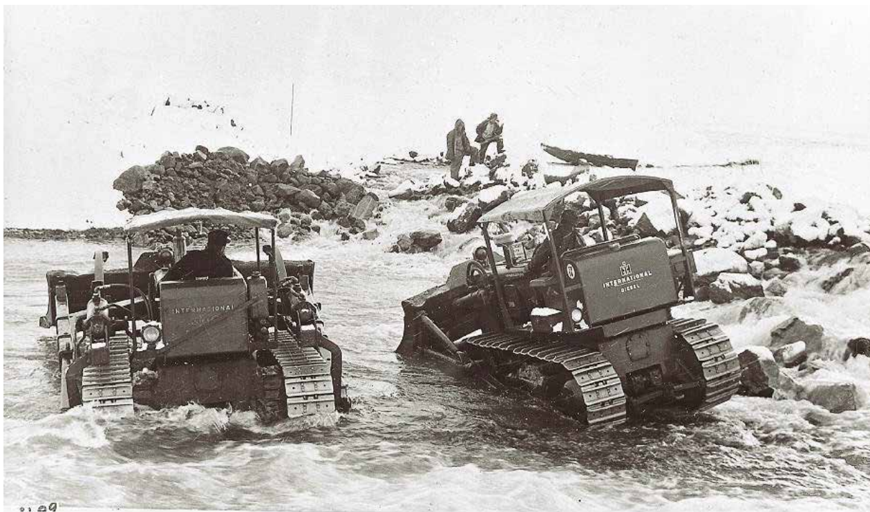
Figur 33. Flottningsrensning med bulldozer. Foto Johan Brun.
