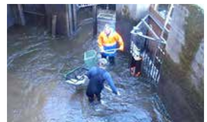
Bild 4. Fiskvägens två ingångar genom ploggrindarna in till fångstbassängen med fiskräknaren installerad i den övre ploggrinden. Manuell hävning pågår. Foto: Stefan Stridsman
