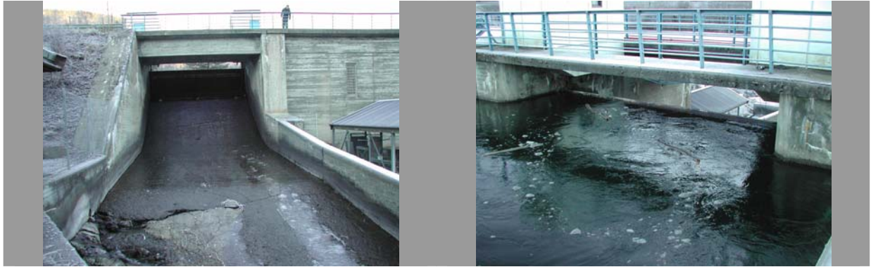
Bilde 6 Isluka sett fra nedstrøms (venstre) og oppstrøms (høyre) posisjon
