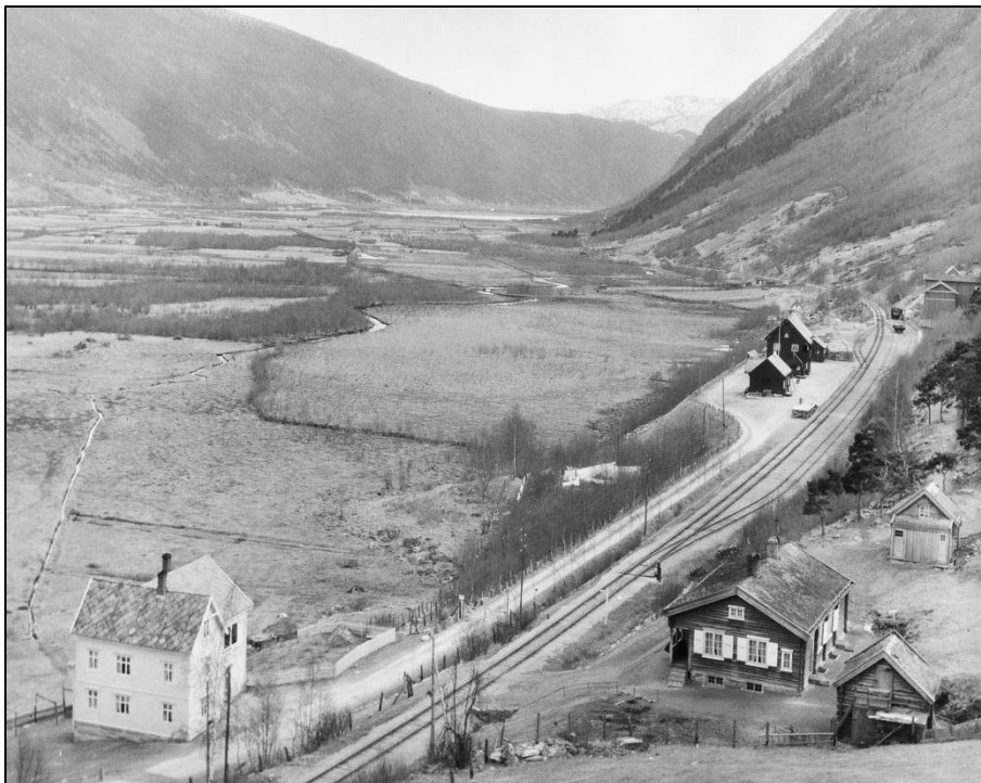
Figur 4. Selsvollene før oppdyrking i 1925. Skottvatnet skimtes i øvre del av bildet. (Foto: A. B. Wilse. Norsk Folkemuseum, Wilsesamlingen ).
