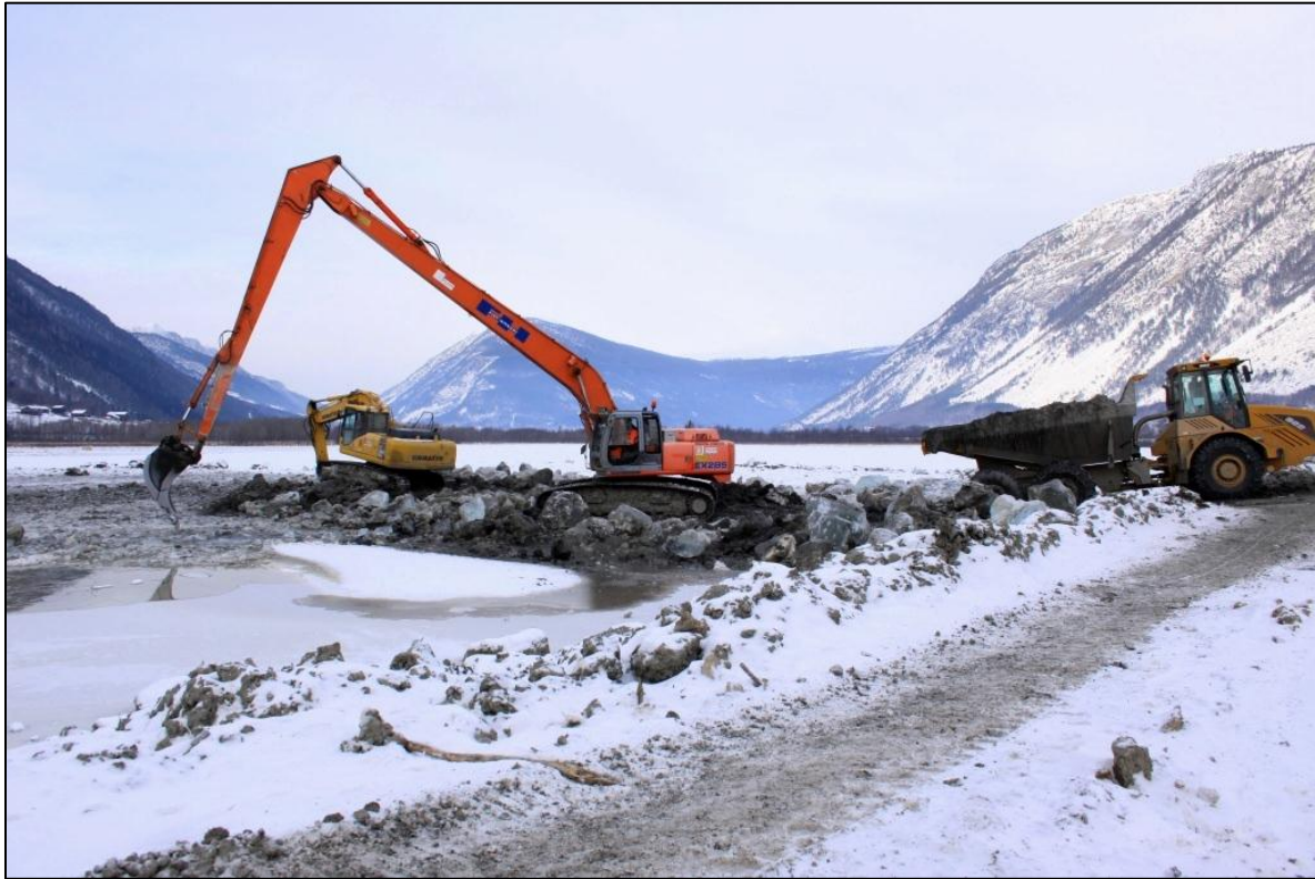
Figur 13. Anleggsarbeid 11.2.2010. Foto: Geir Høitomt
