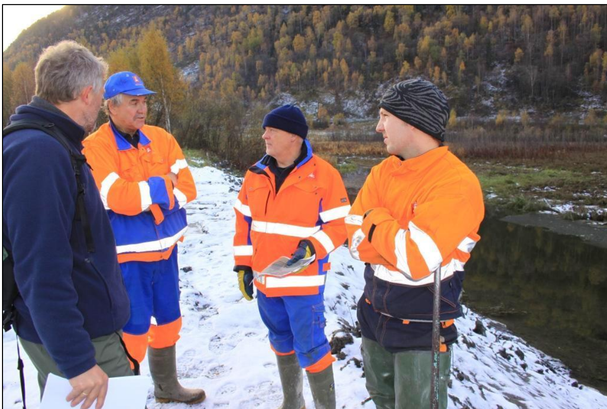
Figur 9. Planlegging ved oppstart av mudring 12.10.2009. Foto: Geir Høitomt
