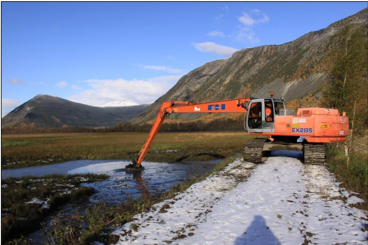
Figur 18. Oppstart av mudringsarbeidet i Skottvatnet naturreservat. Foto tatt 12.10.2009. Foto: Geir Høitomt
