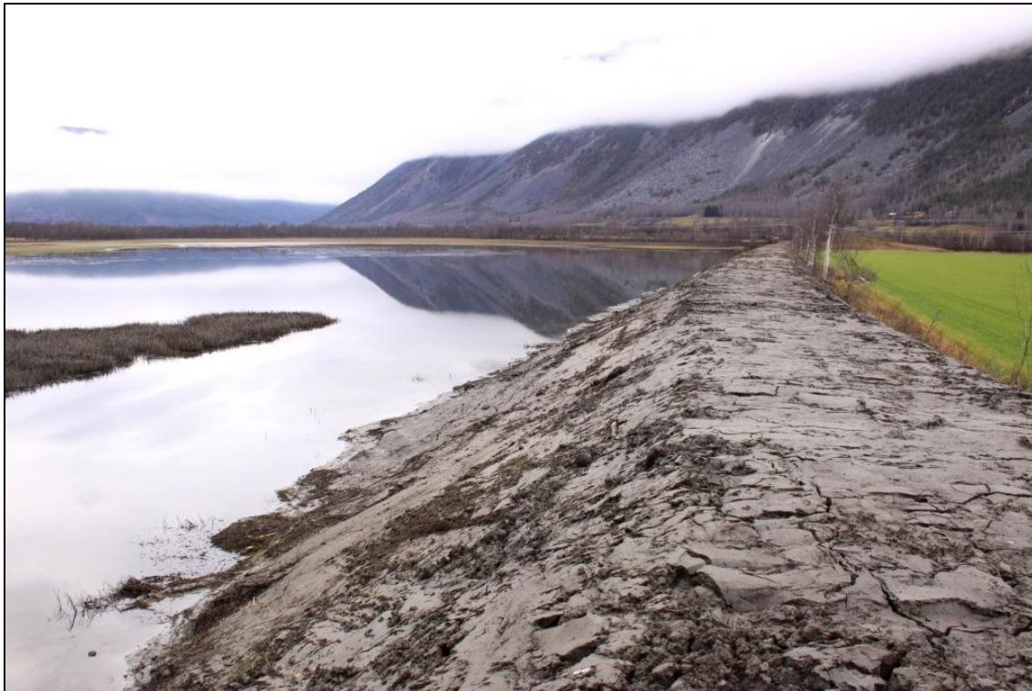
Figur 14. Avsluttet arbeid 7.11.2011. Skansen sett mot nord. Foto: Geir Høitomt
