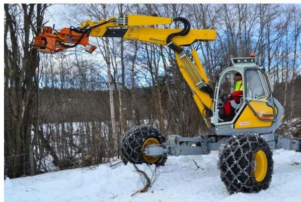
Maskina Menzi Muck i arbeid med rydding langs jordekant i Alvdal. Foto: Magne Sandtrøen
