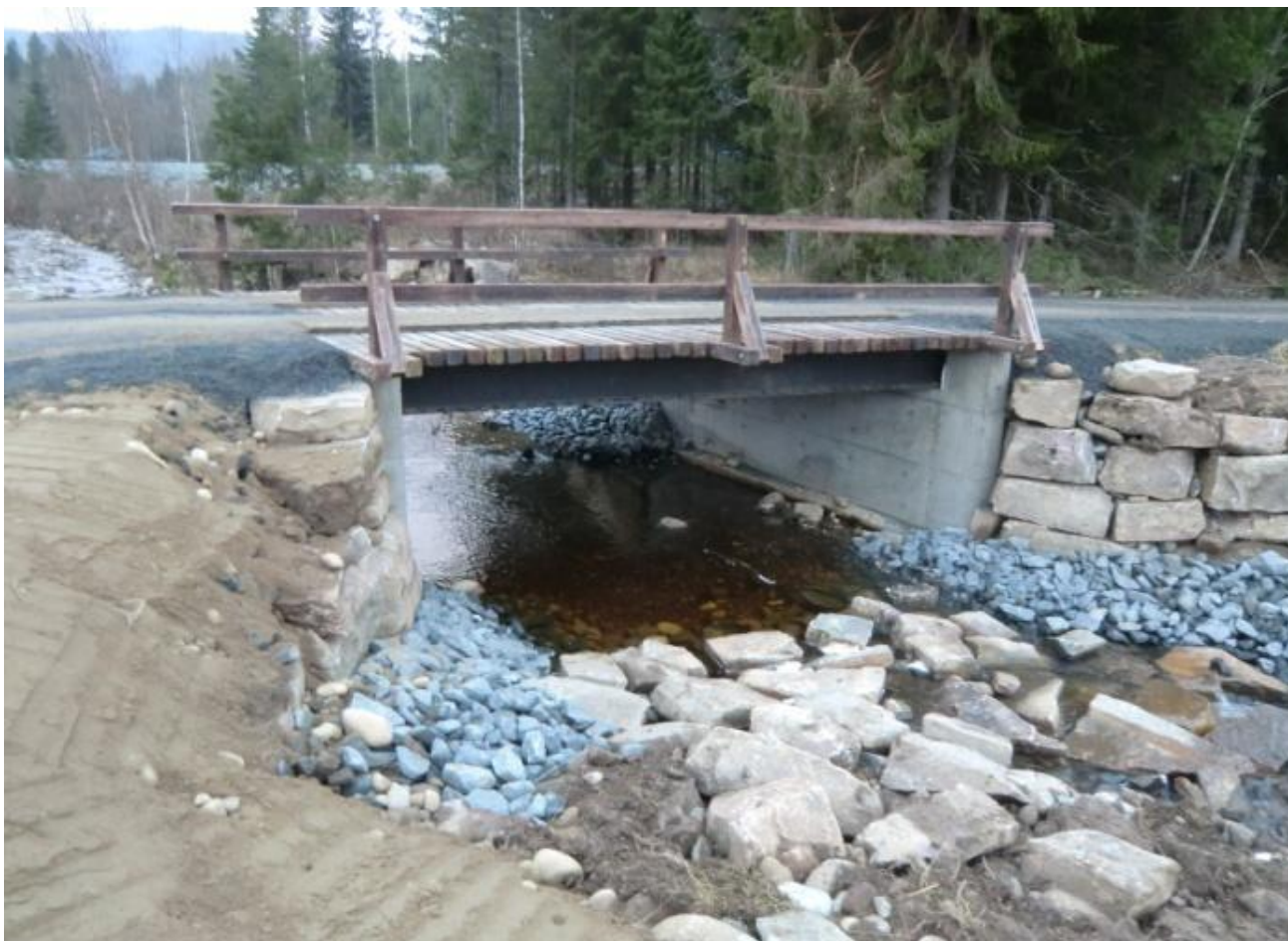
Ombygd bru i Åmot. Foto: Tore Holaker
