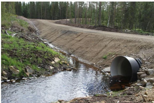
Det ble ferdigstilt 16,5 km nye skogsbilveger i 2015.
