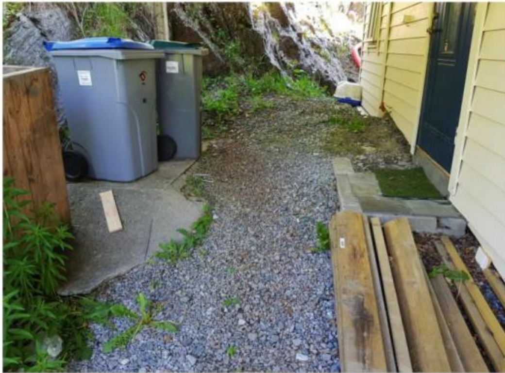
Bilde viser alternativ inngang før utbedring.
