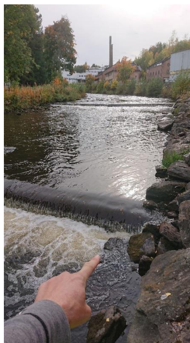
Figur 33. Tersklene i Hunnselvas nedre deler skaper et unaturlig svakt strømbilde.
