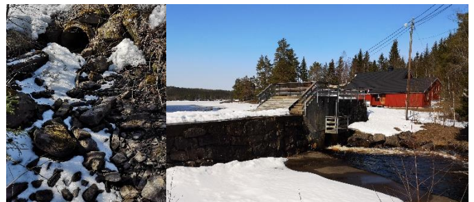
Figur 8: Dammen på Skumsjøen til høyre og flomløpet vest for dammen til venstre.
