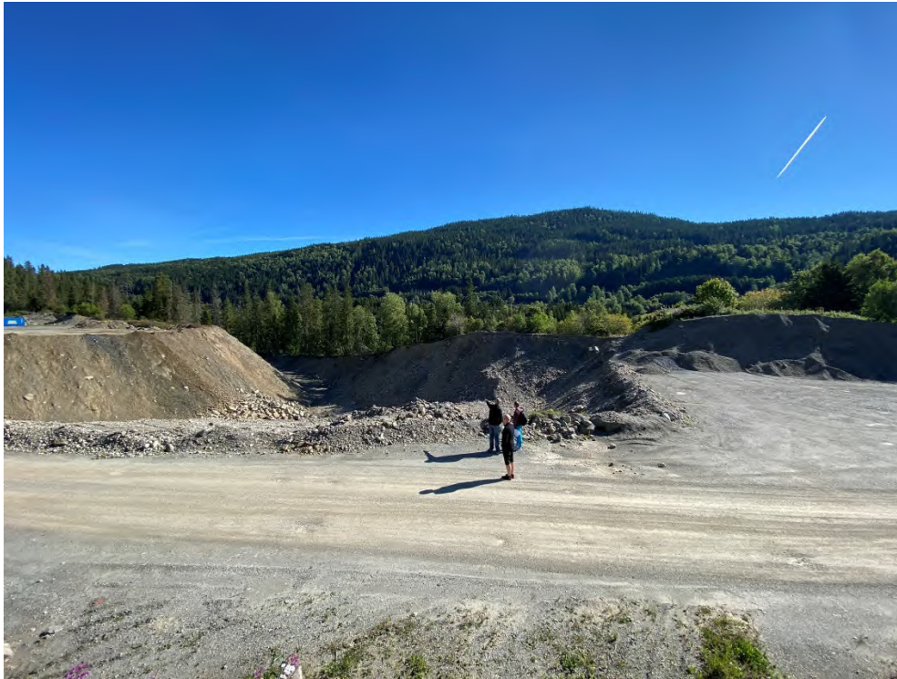
Bilde 1 viser dybden på dagens uttak (ca. 15m målt fra opprinnelig terrenghøyde).
