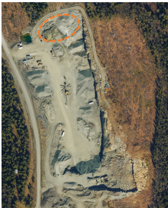
Figur 1. Omtrentlig plassering av lagringssted for asfalt og betong.
