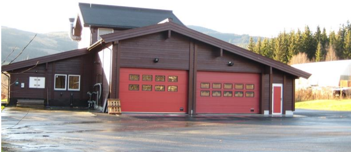
Nedrefoss RA med slammottak skap til venstre
