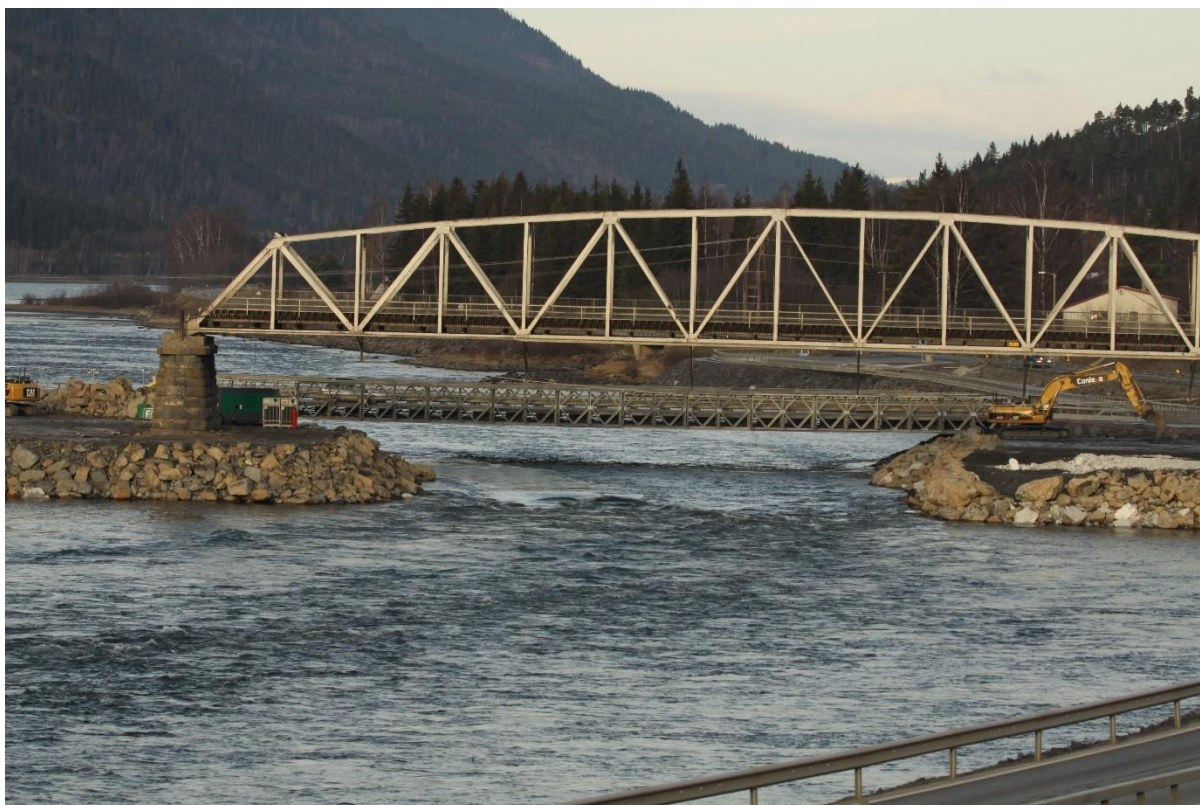
Figur 4. Utskifting av gammel til ny bru gjennom Trettenstryka fuglefredningsområde ble gjort vinteren 2011/2012. Her fra arbeidet 13.11.2011.
