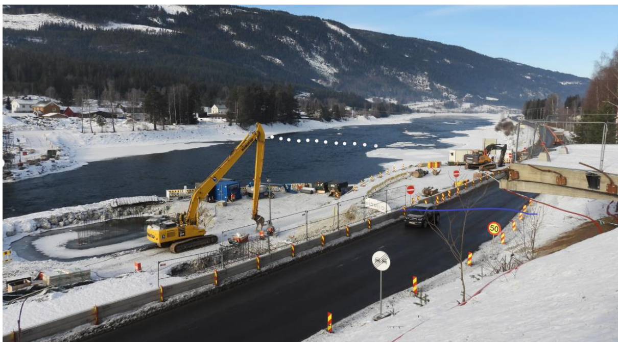
Figur 6. Fra arbeidet med ny brupilar 12.02.2023. Området mellom brua og avmerket felt (hvite prikker) ble vurdert til å være mer stilleflytende enn normalt. Avstanden ned til brustedet ble målt til 130 m.
