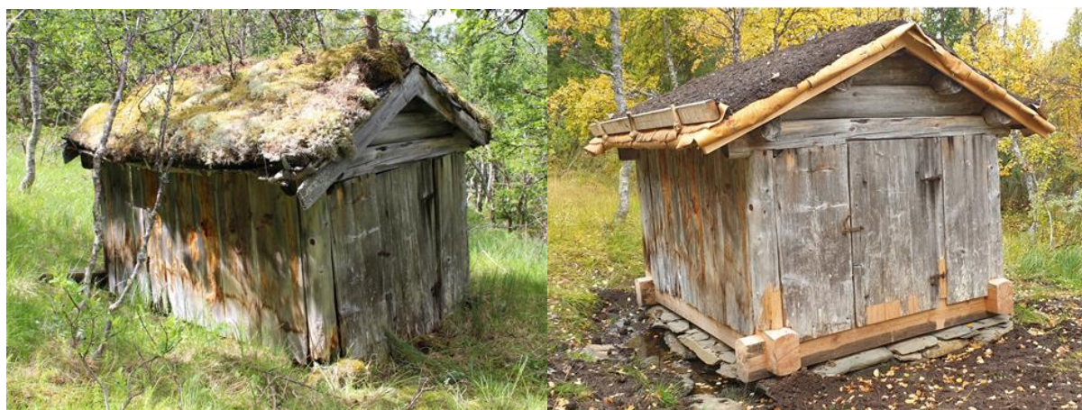
Ei mjølkeavkjøling før og etter restaurering, Håkonsvollen, Kjurrudalen. Taktekking og utskifting av materialer må utføres fagmessig, men fjerning av torv rundt veggene og trær på taket, samt grøfte bort vann kan de fleste gjøre selv. Foto: Per Hvamstad og Berit Siksjø.
