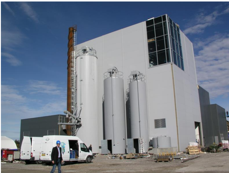
Kraftvarmeanlegget i Kirkenær 2007 (Solør bioenergigruppen) 10 MW (El 2 MW)
