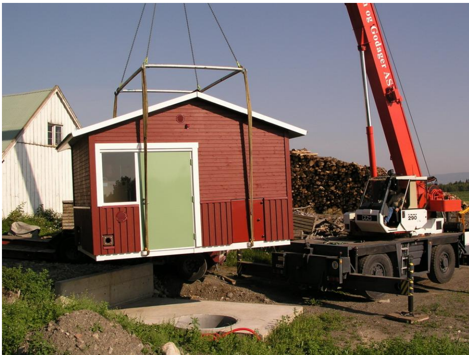
Prefabrikkert flisfyringsanlegg (150 kW) på Fjetre i Stange heises på plass (2004)
