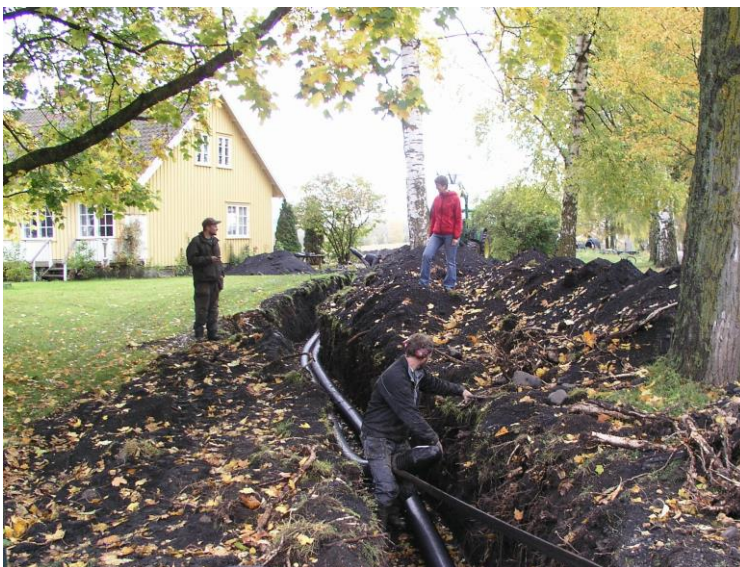
Legging av fjernvarmerør på Grimerud i Stange (2007)
