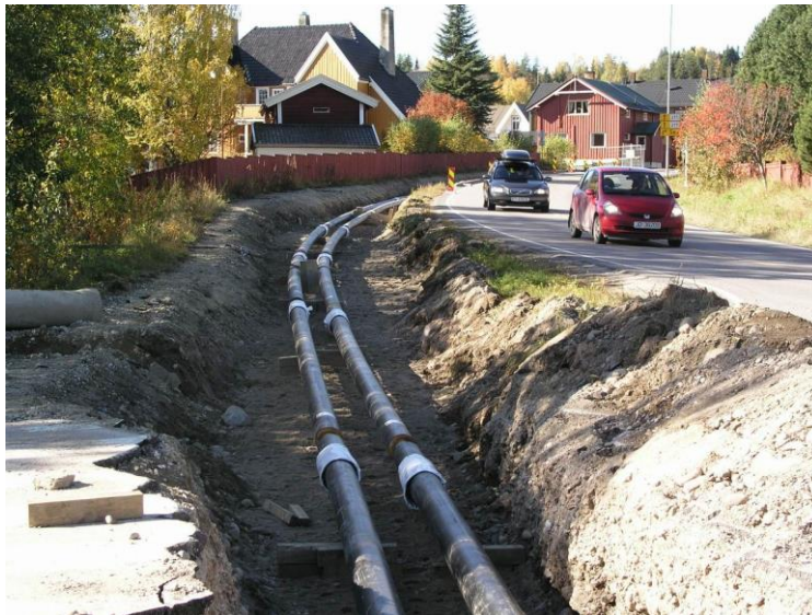
Fra legging av fjernvarme på Rena 2006
