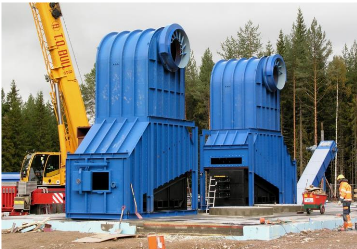
Fra byggingen av 2x 3,5 MW biokjeler ved Rena Leir 2008 (Solør Bioenergigruppen)
