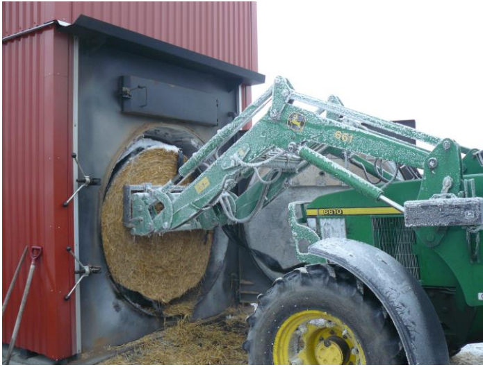
Lading av 500 kW halmfyr på Grimerud i Stange (2007)
