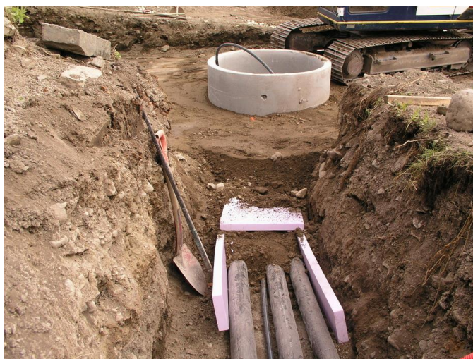
Legging av gardsvarme fjernvarmerør på Fjetre i Stange 2004
