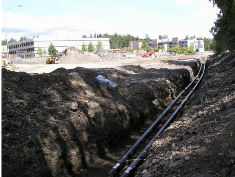
Fra legging av fjernvarme ved skoleanleggene Hamar Vest 2006
