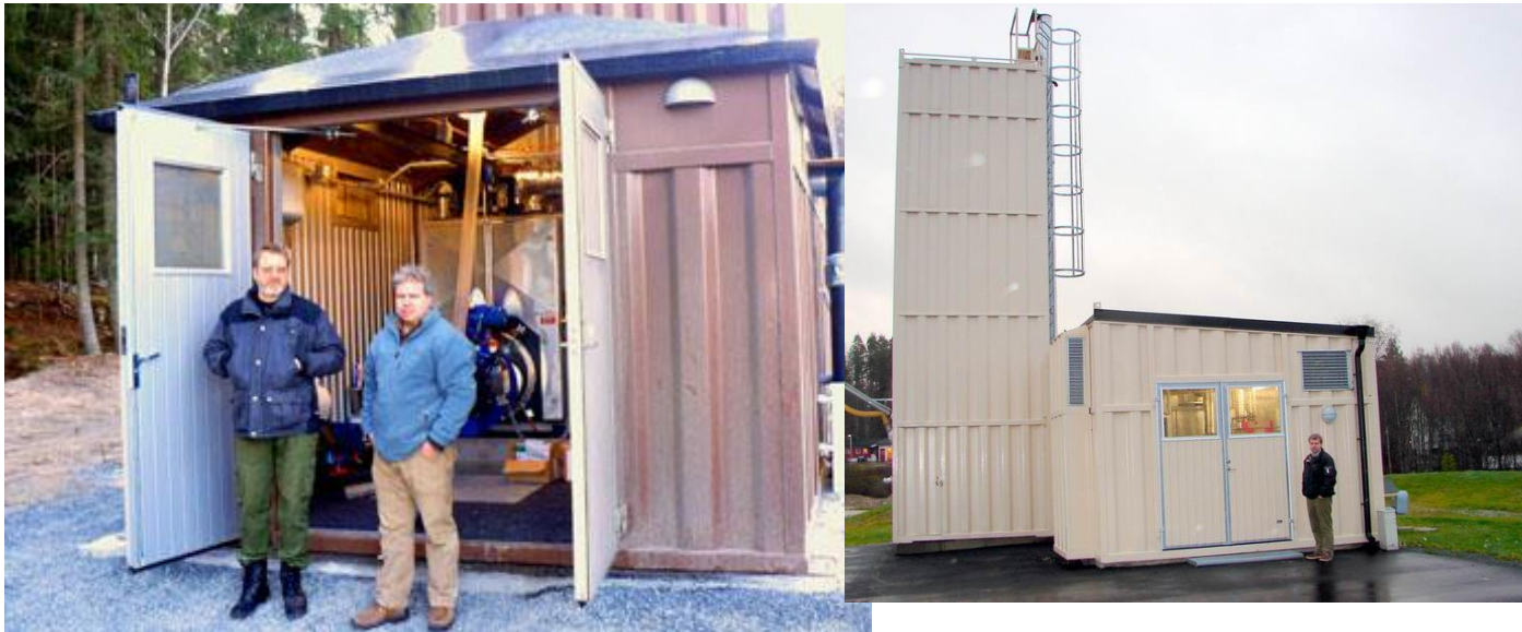
Pelletsfyrte anlegg i Nord-Odal hver med 0,4 MW pelletsbrenner (Odal Biovarme AS).
