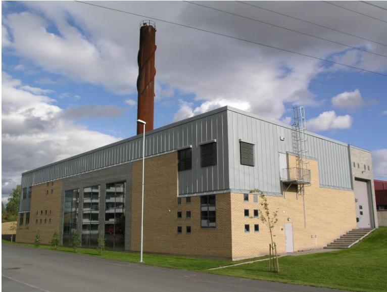
Børstad varmesentral (5,5 MW bio) Hamar Hamar-reg.Fj.varme AS 2003
