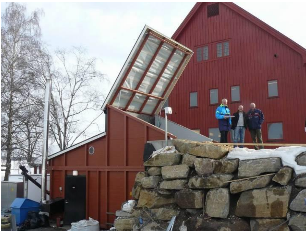
Nytt bioenergianlegg på Blæstad april 2009
