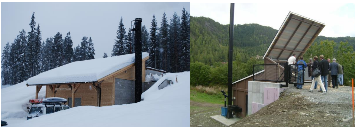
To nye fjernvarmeanlegg: Torpa Biovarme på Torpa og Oplandske Bioenergi sitt anlegg i Bagn
