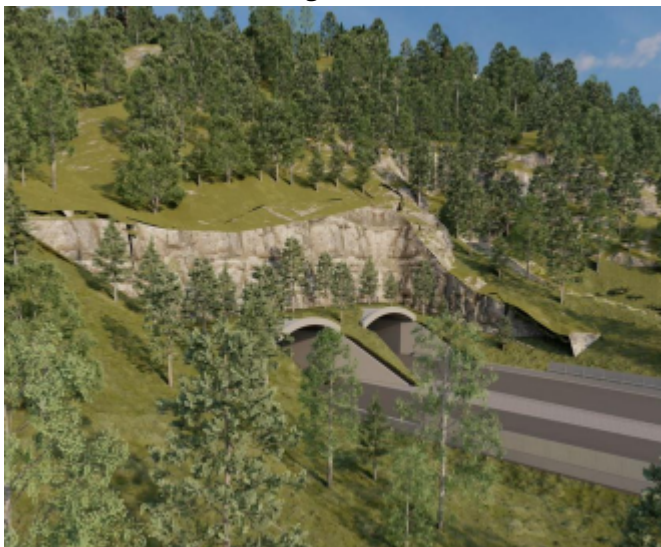
Figur 1: Statsforvalteren anbefaler kommunen å gi føringer om å forlenge tunnellopene noe slik at det vil være mulig å fylle tilbake mot påhuggsområdet. Dette er viktig or å dempe negative landskapsvirkningene av portalområdene.
