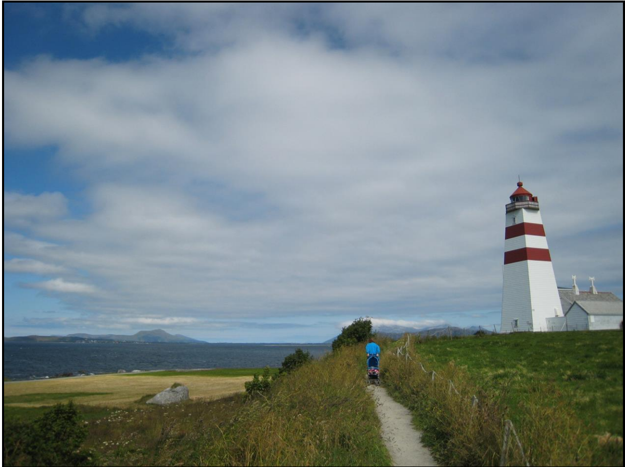
Alnæs fyr. FOTO: Sveinung Dimmen
