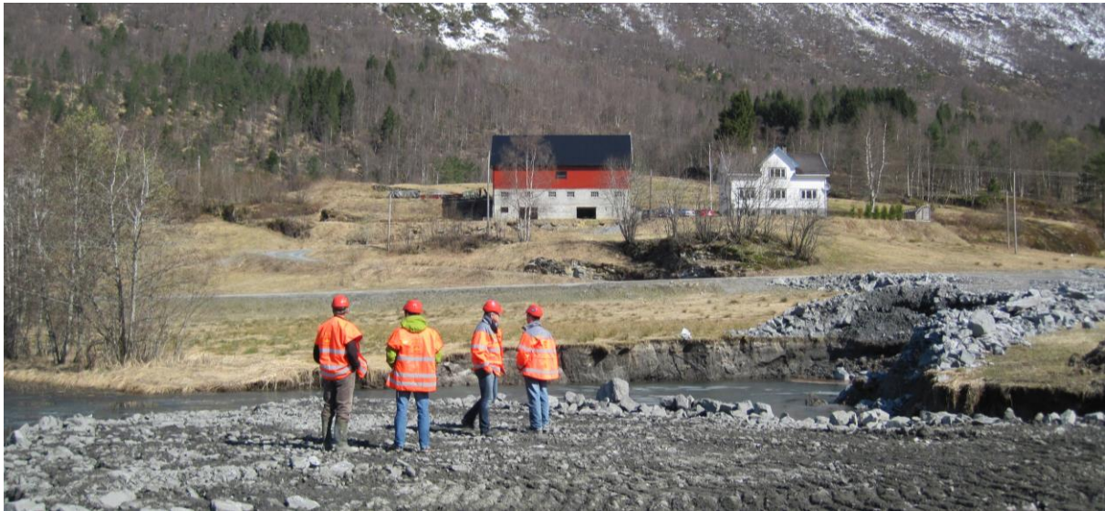
Frå arbeid med Kvivsvegen. Foto: Fylkesmannen.
