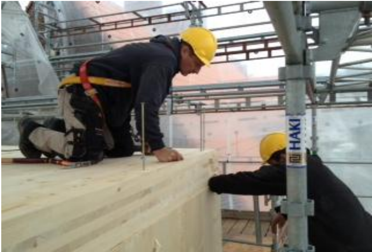
Bilde 8. Massivtre under montering under tak på Grefsen vgs. Undervisningsbygg i Oslo
