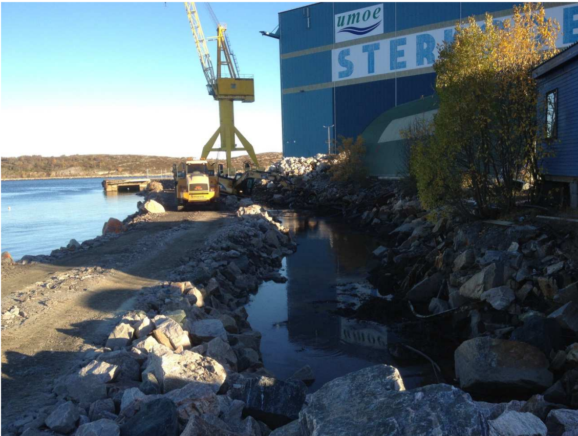
1. Etablering av vei i sjø for sikrere opprydding av fyllingskanten.
