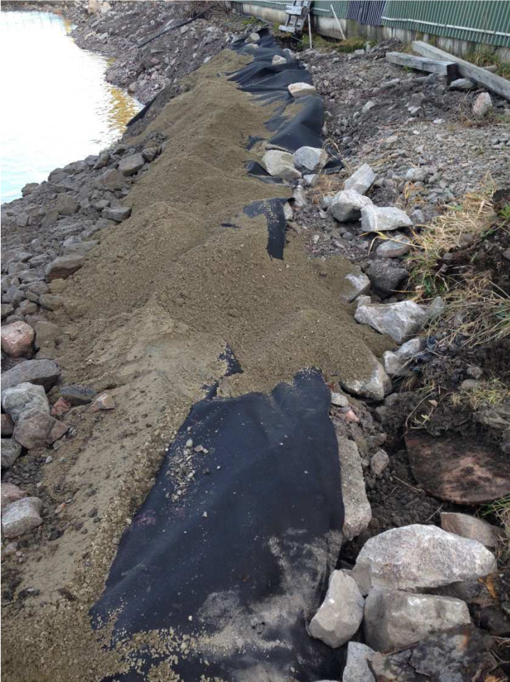
4. Duk og filterlag er lagt ut.
