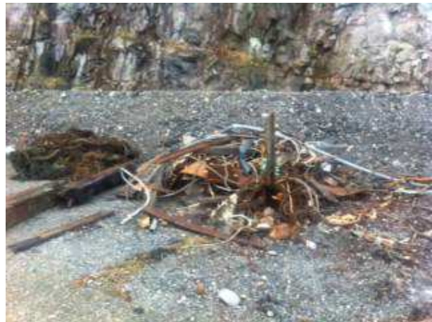
2. Opprydding i sjøkant. Fjerning av synlig skrot. Entreprenøren har foreløpig lagt skrotet til side. Det består av jernskrot og plast. Det skal bli levert til godkjent mottak.
