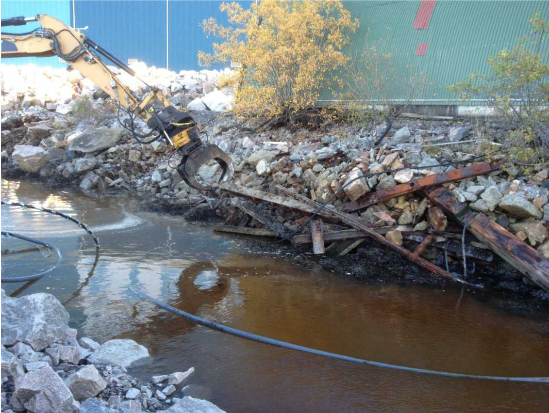
2. Opprydding i sjøkant. Fjerning av synlig skrot. Entreprenøren har foreløpig lagt skrotet til side. Det består av jernskrot og plast. Det skal bli levert til godkjent mottak.
