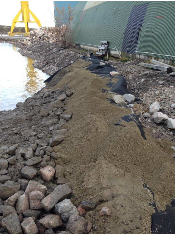
5. Beskyttelseslag på filterlag
