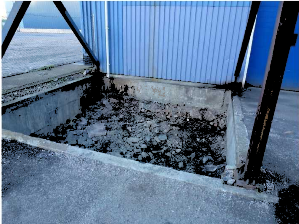
Figur 4. Plassen hvor dieseltanken tidligere var plassert. Forurensete masser er fjernet ned til fjell.
