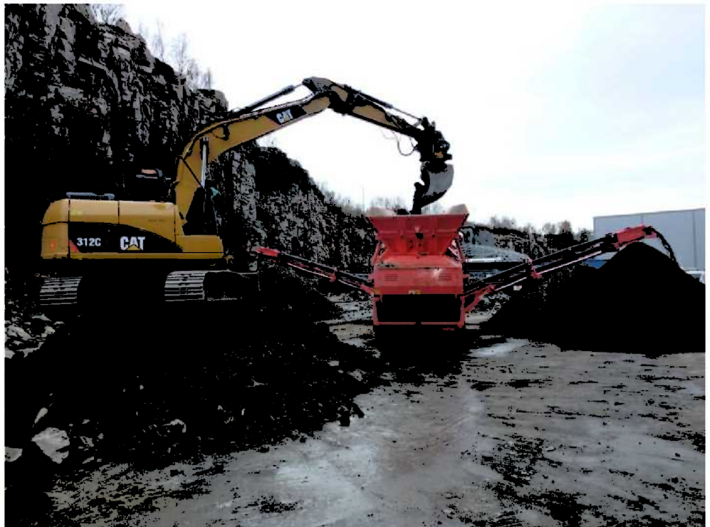
Figur 3. Sikting av forurensete masser ved Umoe Sterkoder. Finmassene ble sendt til godkjent mottak, mens stein og grove fraksjoner ble lagt tilbake.
