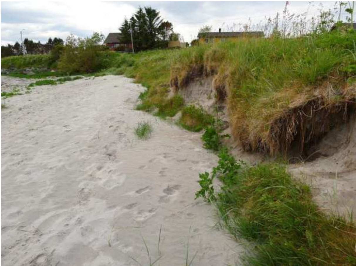
Figur 4.26. Erodert dynekant ved Roald.
