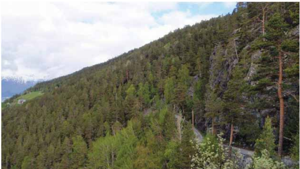
Figur 5. Garden Ansok i bakgrunnen. Skiljet mellom dei to avgrensa furuskogane går langs gardsvegen. Det burde kome fram av bildet at her er rikeleg med kompakt og virkesrik furuskog. Foto: Dag Holtan.
