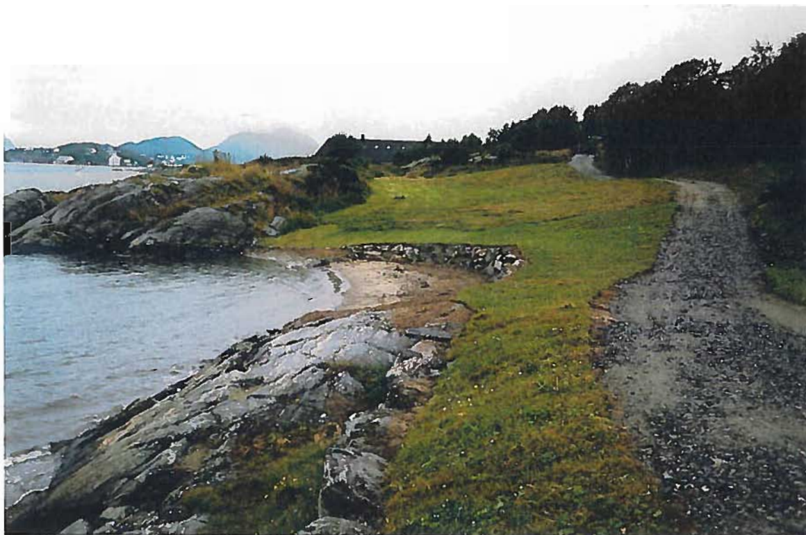
Fig. 7 Reparasjon av øydelagt strandlinje, Voldsdalsberga.
