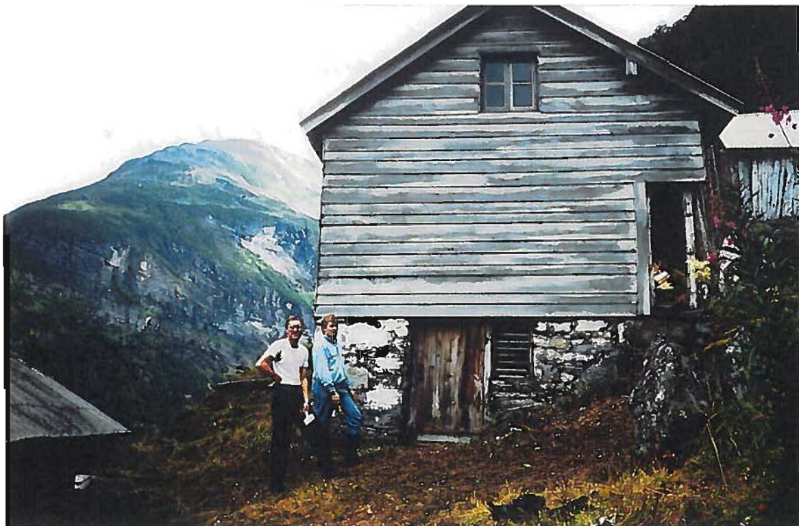
Fig. 16 Reparasjon av øvstestova på Skageflå, Stranda kommune. (Foto: Atle Ringseth 1993)
