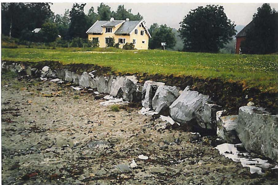
Fig. 8 Reparasjon av strandlinje, Emblemsanden.
