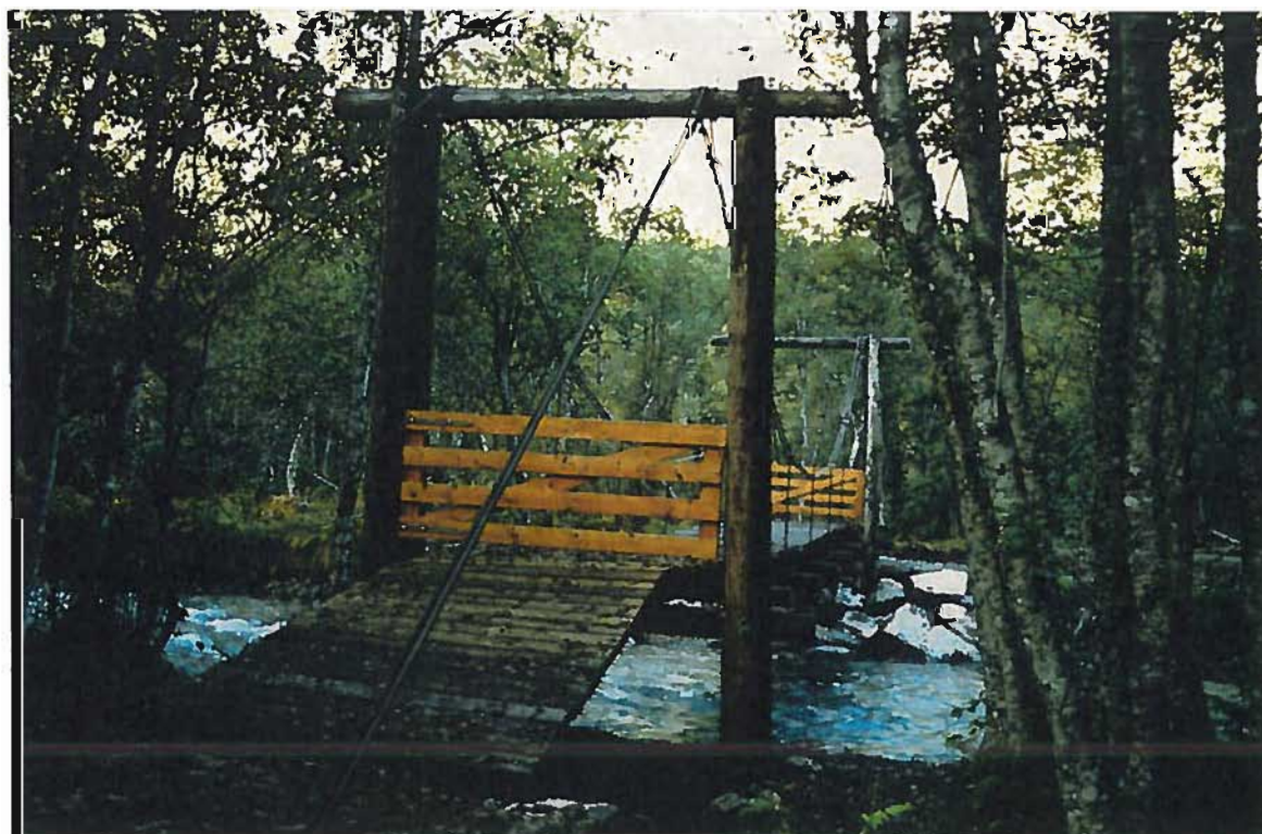
Fig. 20 Ny hengjebbru over Istra i samband med "Kløvstien".
