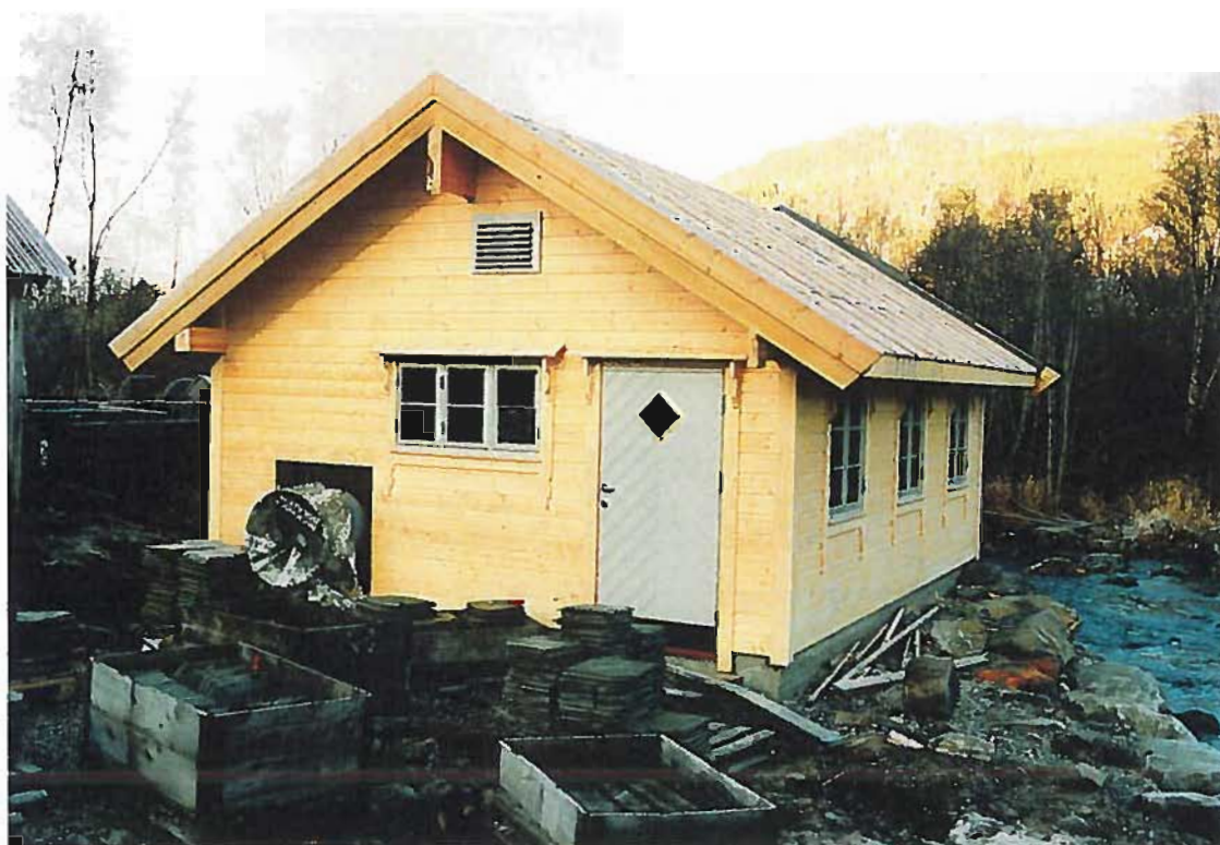
Fig. 14 Oppsetting av nytt kraftverk ved Øyraelva, Volda.
