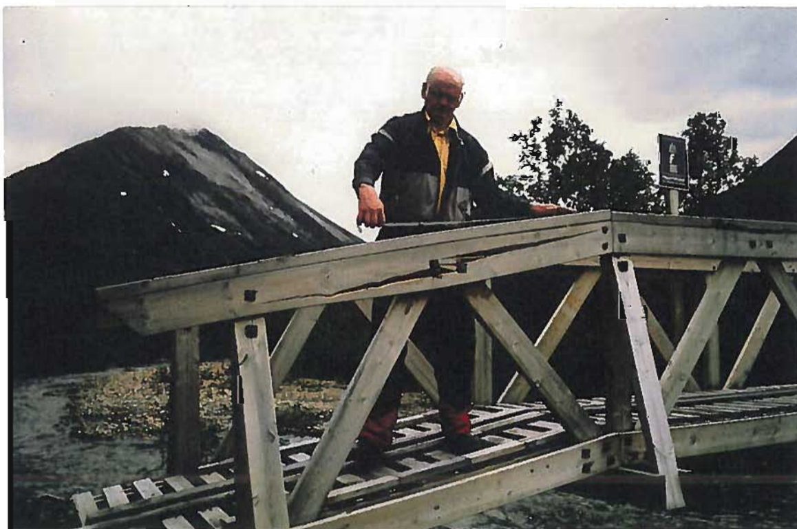
Fig. 25 Reparasjon av Elvabytebrua i Stordalsfjella. (Foto: Magnhild Vatn 1993)
