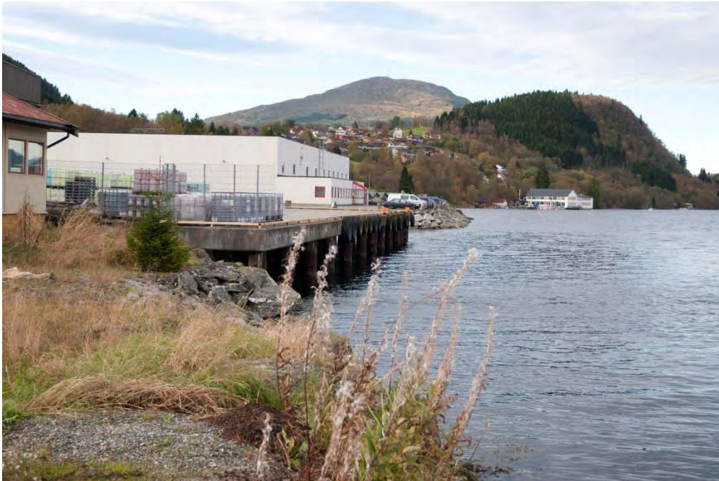
Figur 68: Industriområde på sør-vestsiden av Ørsta sentrum(4).
