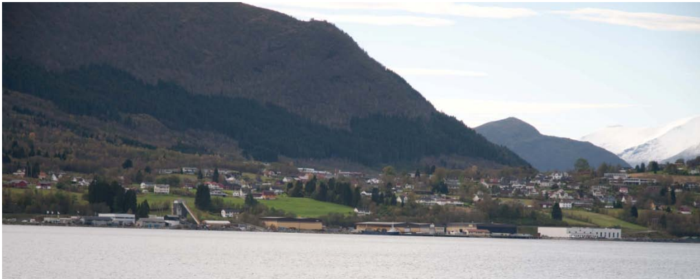
Figur 65: Industriområde på sør-vestsiden av Ørsta sentrum (1).
