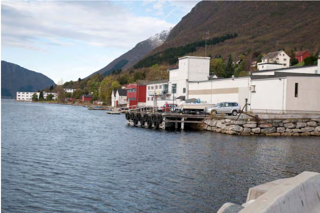
Figur 59: Fra nordlige del av Ørsta sentrum, mot vest.
