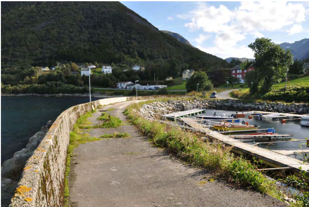
Figur 45: Nordre Vartdal, småbåthavna, sett mot øst.
