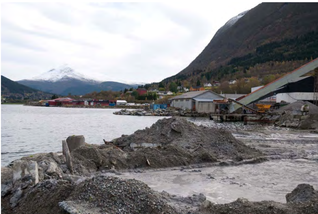
Figur 67: Industriområde på sør-vestsiden av Ørsta sentrum(3).
