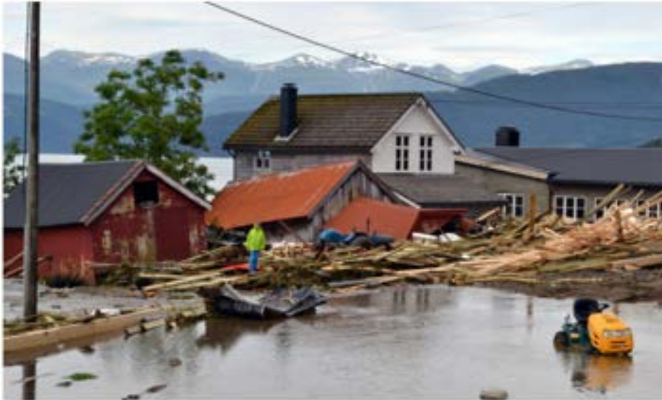
ENORME SKADER: I fjor sommer ble bygda Utvik i Sogn og Fjordane rammet av flom, etter enorme nedbørsmengder på kort tid. På grunn av klimaendringene forventes det mer av denne typen ekstremnedbør i framtida. Foto: Hans Ivar Moss Kolseth / NTB scannet
