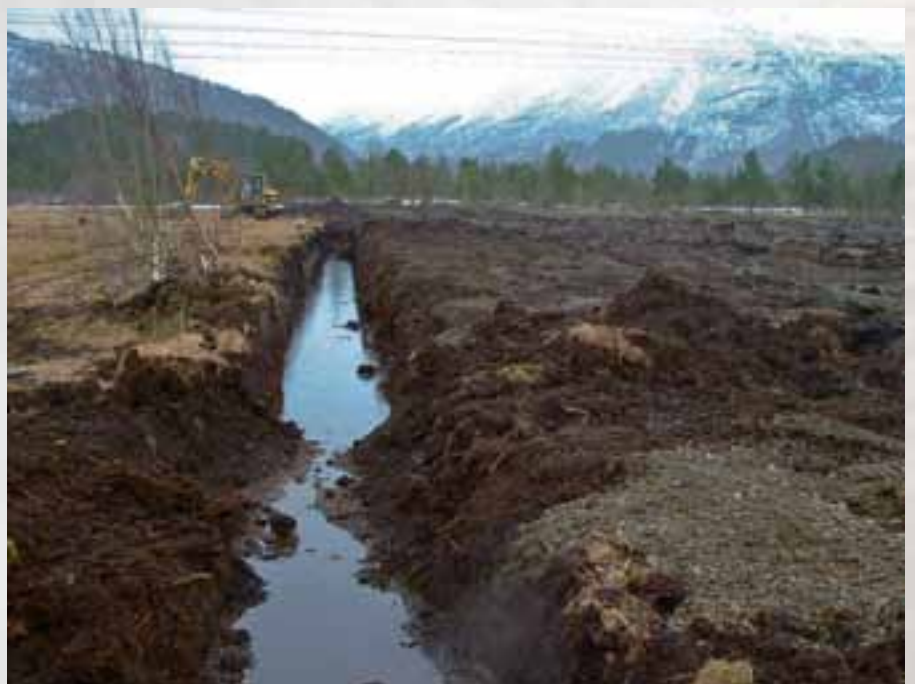
Bilde 1. Gunnar Aaram i arbeid med å gjere myr til fastmark. Foto: Ivar Bakken.
