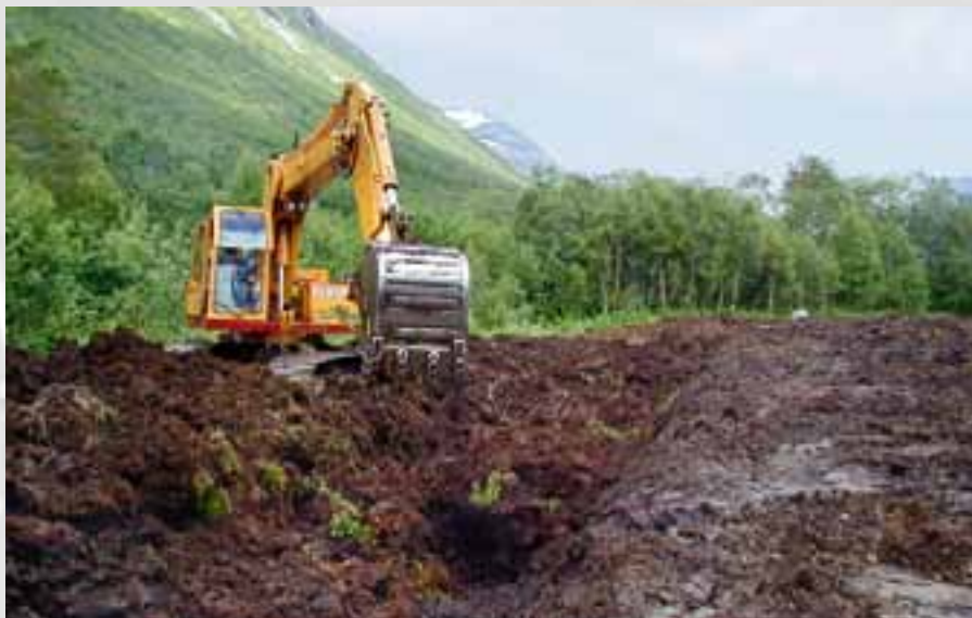
Drenering av myr ved omgraving. Foto: Ivar Bakken.
