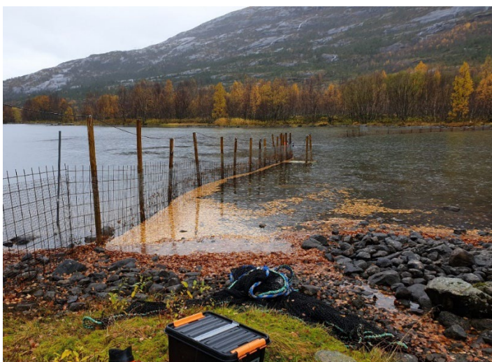
Bilde: Ledegjerde under demontering på lav vannføring i oktober 2022. Nota som ble brukt til å sperre av midtre deler ses i forgrunnen. Foto: Aslak Darre Sjørnsen.
