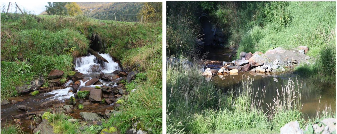
Figur 10 Bilder av kulvert under privat vei.
