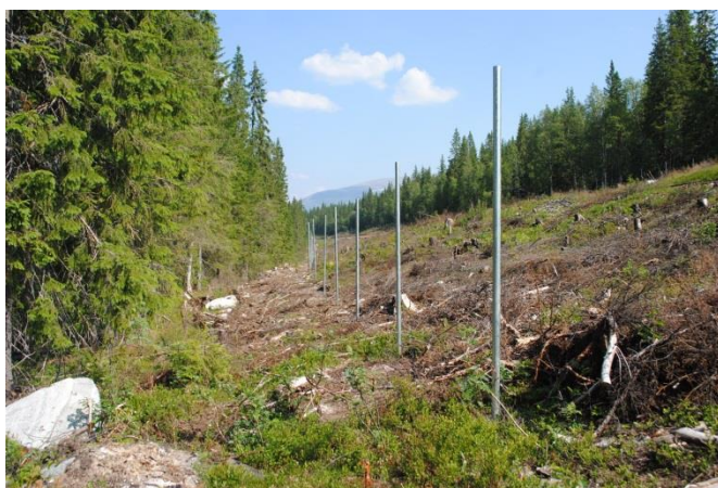
Figur 10: I 2014 ble det satt opp viltgjerde på begge sider av jernbanen. Her er gjerdet under oppføring. Foto: Åsmund Andersen.
