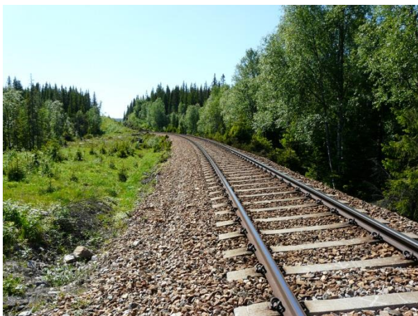
Figur 8: Jernbanen krysser 3 km av reservatet. Bildet er tatt før viltgjerdet ble satt opp. Foto: Gudrun Hagen.
