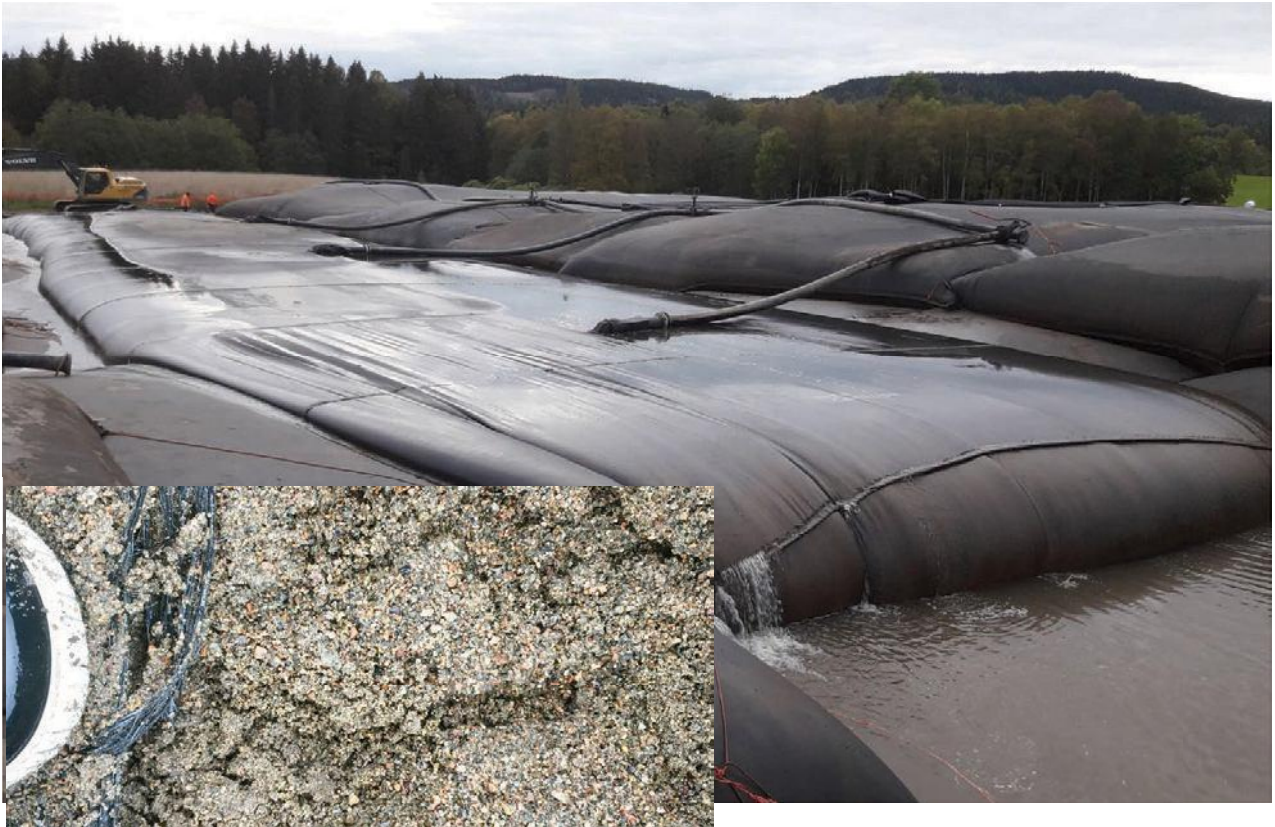
Figur 2. Fylling av Geotube 31. Nummer 23 og 24 er plassert over denne (figur 1). Nærbilde av sand, revet Geotubetekstil og "tuppen av en støvel størrelse 45" fra topp Geotube nummer 24.
