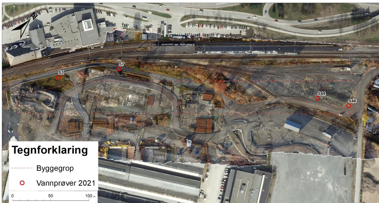
Figur 4: Plassering av vannprøver tatt ut på tiltaksområdet 29.03.2021
