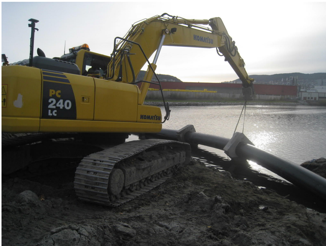
Figur 2-5: Bilde fra installeringen av eksisterende sjøvannsledninger i 2010, sjøvannsledning med lodd.
