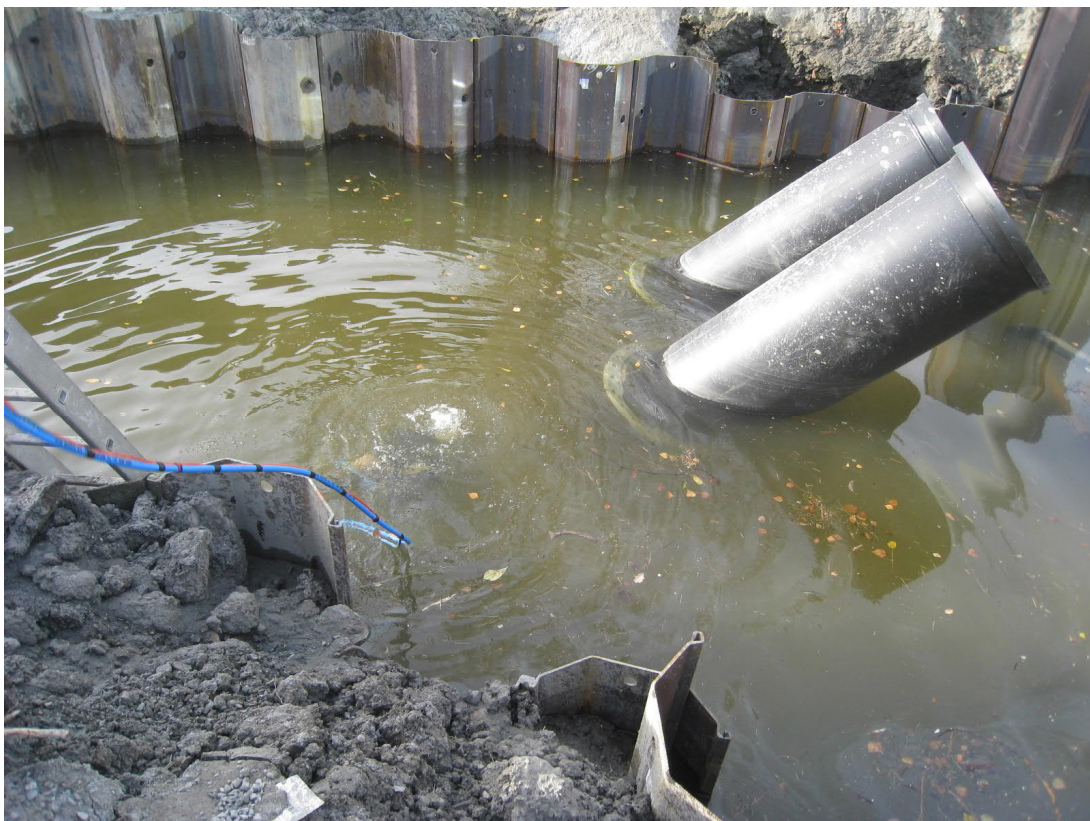
Figur 2-4: Bilde fra installeringen av eksisterende sjøvannsledninger i 2010.
