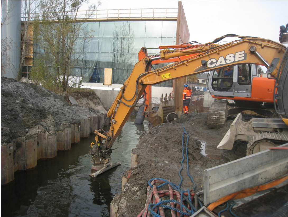
Figur 2-3: Bilde fra installeringen av eksisterende sjøvannsledninger i 2010, spuntet grøft.
