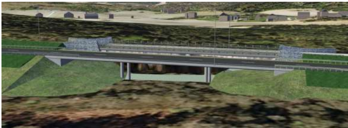
Figur 3-22: Holtbråtte bru og viltundergang
