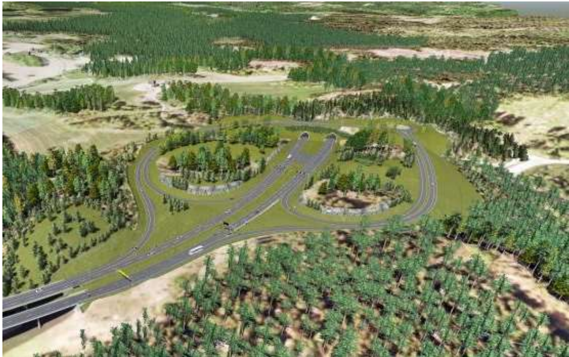
Figur 3-25: Kryssområdet på Bråtan sett fra Bråtan bru mot Frogntunnelen. Rampene mot Nesodden bygges ikke i byggetrinn 2.
