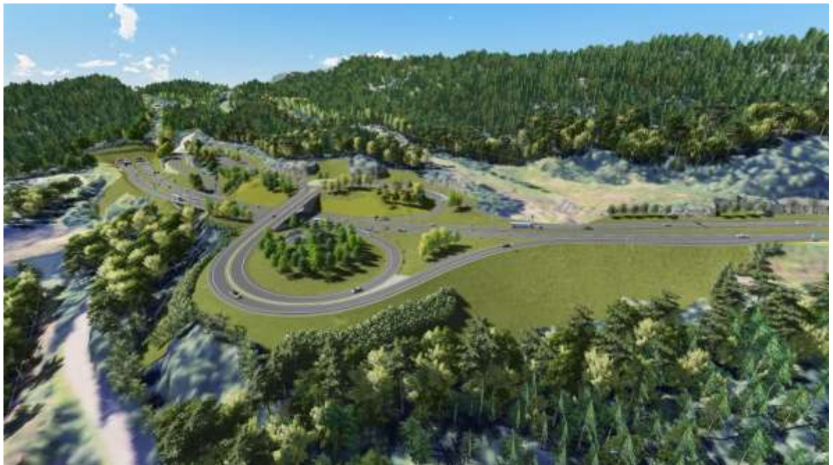
Figur 3-15: Kryssområdet på Verpen sett mot Oslofjordtunnelen
