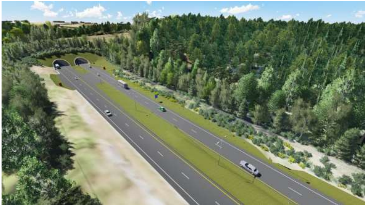
Figur 3-27: Ny kjørebane på rv. 23 sett østover mot Vassumtunnelen
