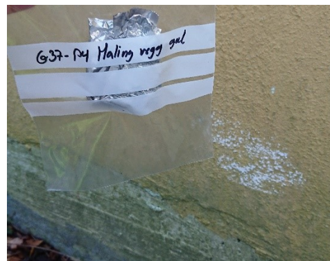
Bilde B4: Prøve nr. G37-P4 Gulmaling på betongvegg utvendig
