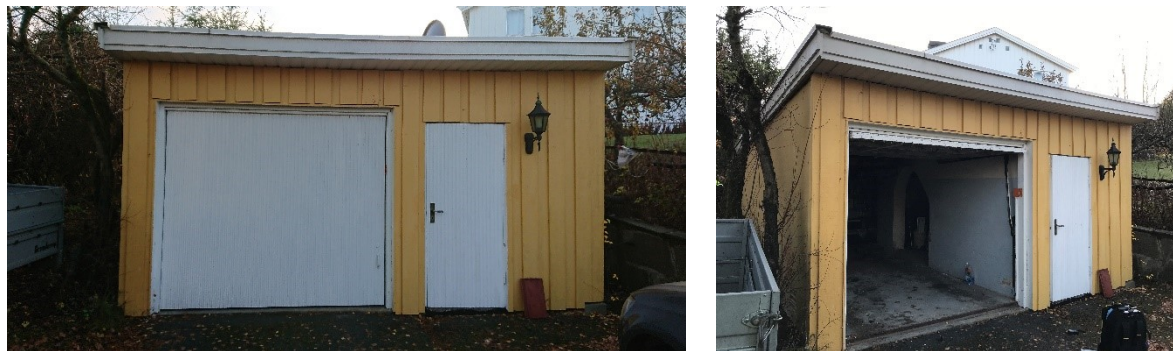
Figur 2: Fasadebilder av garasjen
