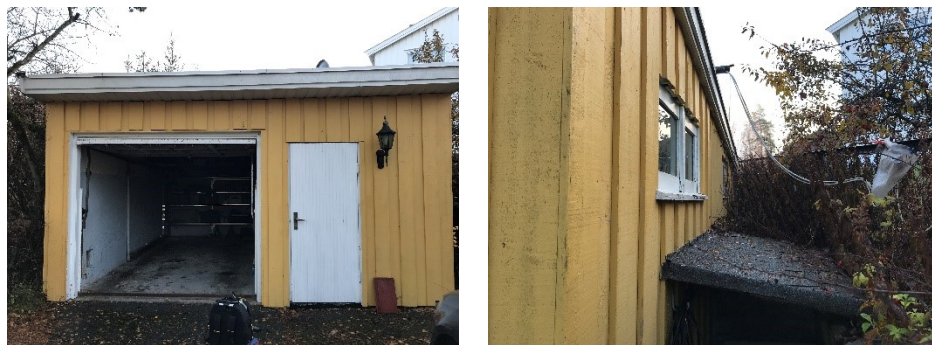
Figur 3: Fasadebilder av garasjen
