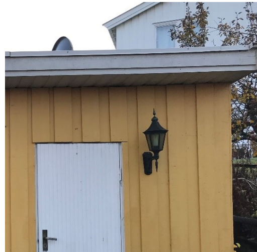
Bilde B8: Sparepære i lampe utvendig på garasje
