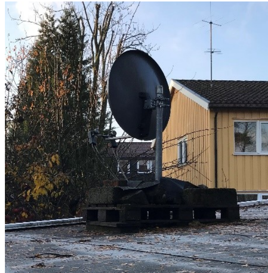
Bilde B6: Parabolantenne på garasjetaket
