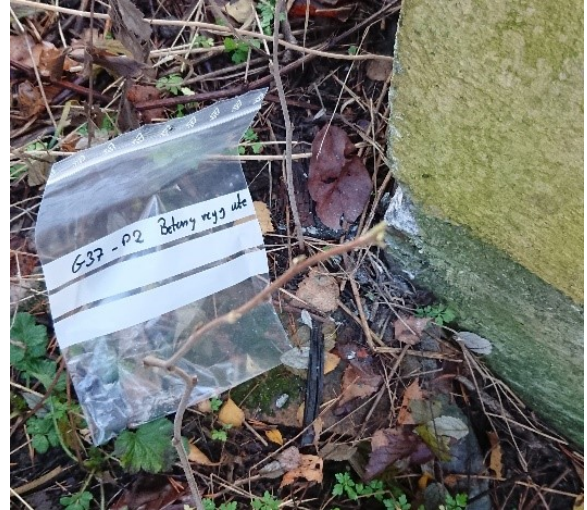
Bilde B2: Prøve nr. G37-P2 Betong fra betongvegg, utvendig
