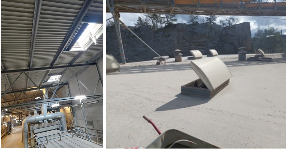
Figur 5: Lufteluker i taket i produksjonshallen, sett nedenfra (venstre) og fra taket (høyre).
