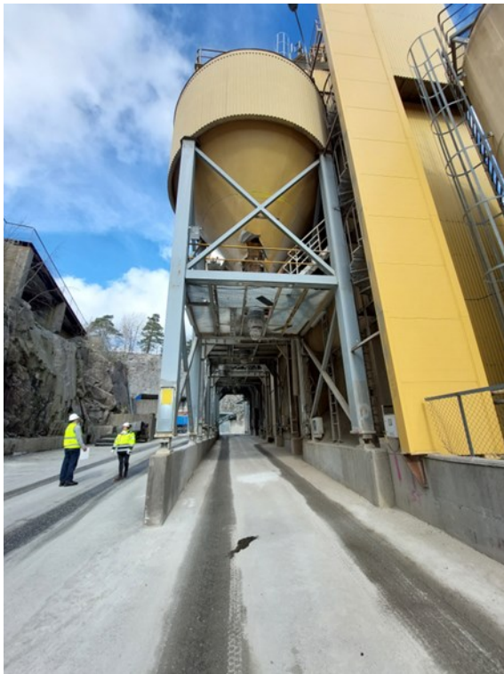
Figur 3: Lagringstanker for finmalt glasstøv. Lastebiler kan kjøre inn under tankene og fylle finmalt glass for frakt til anlegget i Skjåk (venstre bilde). Finmalt glass tappes gjennom egne tappekraner (høyre bilde).
