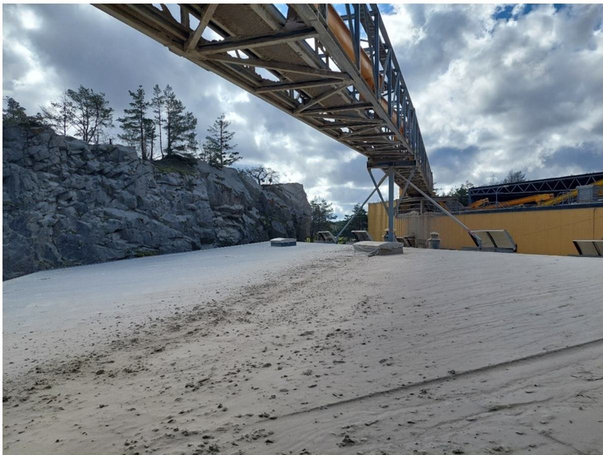
Figur 8: Synlig støv på taket av selve produksjonshallen. Bildet er tatt i sørlig retning under befaring 19. april. Det sees tydelig et tykt lag like under transportbåndet. Området til høyre ligger i le bak bygningen i forhold til vinden og det bygger seg opp et støvlag. Området til venstre er mer vindutsatt og støvet blåser bort, også kalt gjenoppvirvling («resuspension»).
