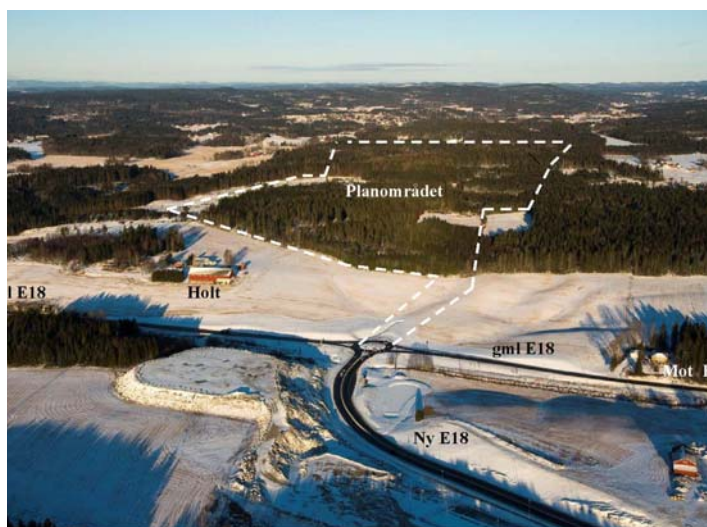
Ferdigstilt del av nye E18 frem til Holt/Knapstad
