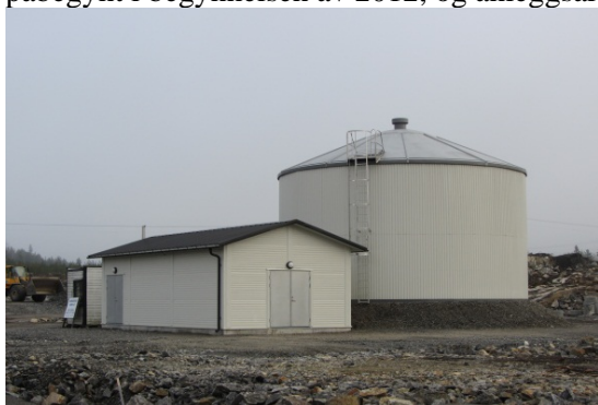
Eksempel på trykkvannsbasseng.
