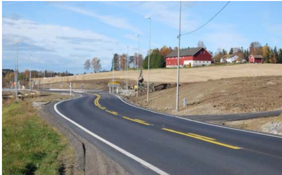
Siktforhold langs Fv 128 inn mot rundkjøring.
