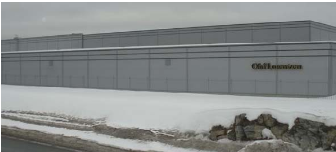
Oluf Lorentzen – lager/logistikk - byggehøyde ca 18 m
