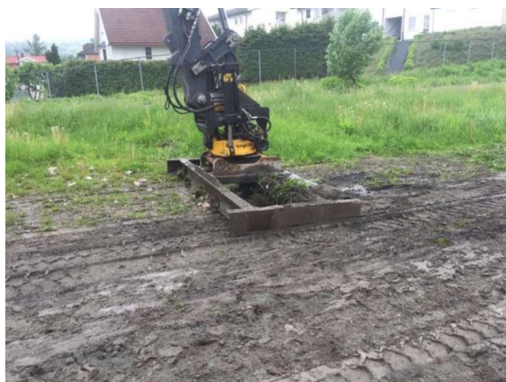
23. Avskraping med avrettingskjær, 11.6.2019.
