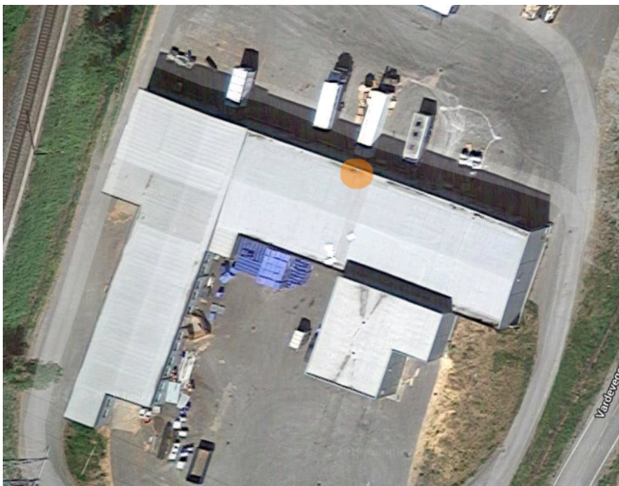
Bildet 4. Reserve propankjele i øvre vaskehall til oppvarming av varmt vann. Ikke sannsynlig med forurensning til grunn da propan er ikke registreringspliktig og flyktig gass.
