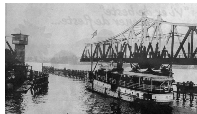
Figur 16 Jernbanebroen over Strømsø-løpet svinger for å åpne for båt-trafikk
