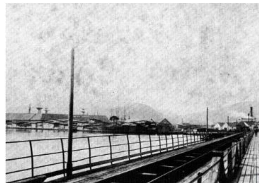
Figur 6 Jernbanebro med gangbro over til Holmen, sett fra Brakerøya
