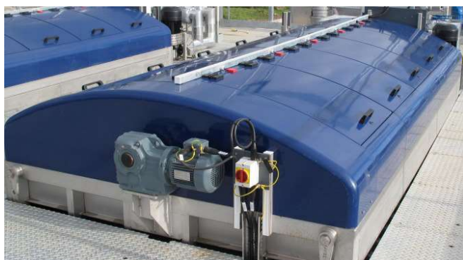
Figur 13: Illustrasjon av et diskfilter og virkemåte (kilde: Nordic Water, DynaDisc)
