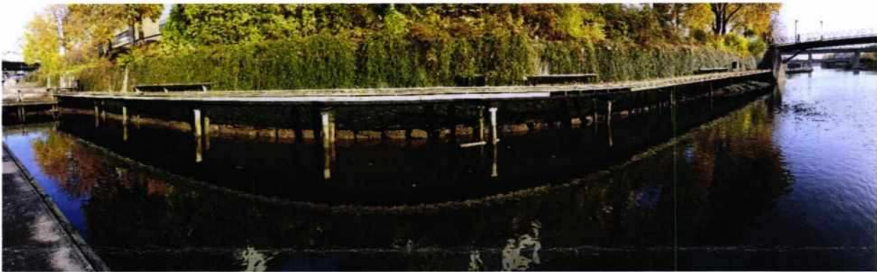
Figur 2.1 – Panoramabilde av eksisterende støttemur og brygge ved etappe 2 av prosjektet Sandvika elvepromenade.
