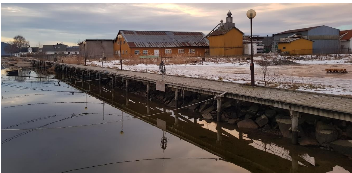
Figur 13 Utfylling med stein for stabilisering av løsmasser og hindre erosjon og utgliding er synlig under bryggen. Foto: Sweco Norge AS
