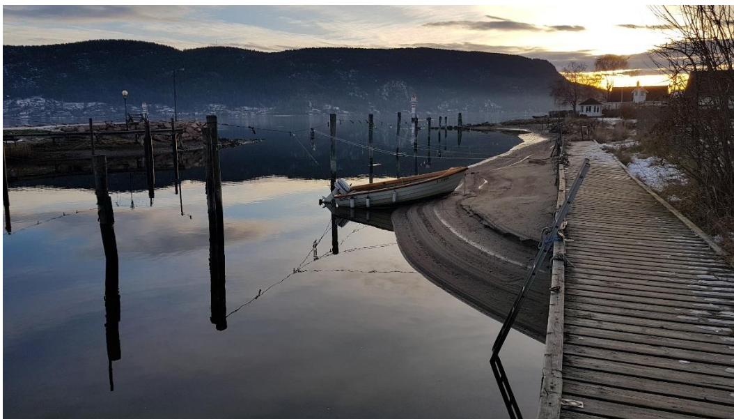
Figur 12 Sand som har bygd seg opp langs land har laget litt grunne båtplasser når det er lavvann. Sweco Norge AS
