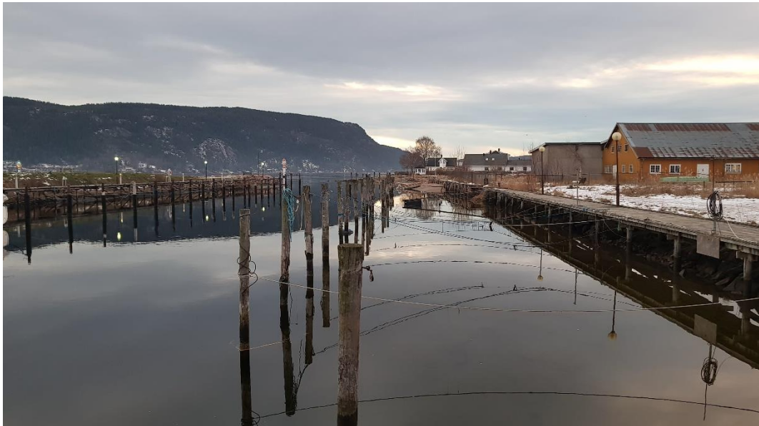
Figur 7 Stasjon 2 ved trestolpe nr 2 fra kamera. Foto: Sweco Norge AS
