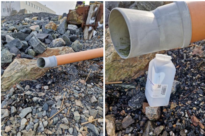
Figur 11. Bilder som viser utløp av overvannsrørledning (prøve utløp 1).
