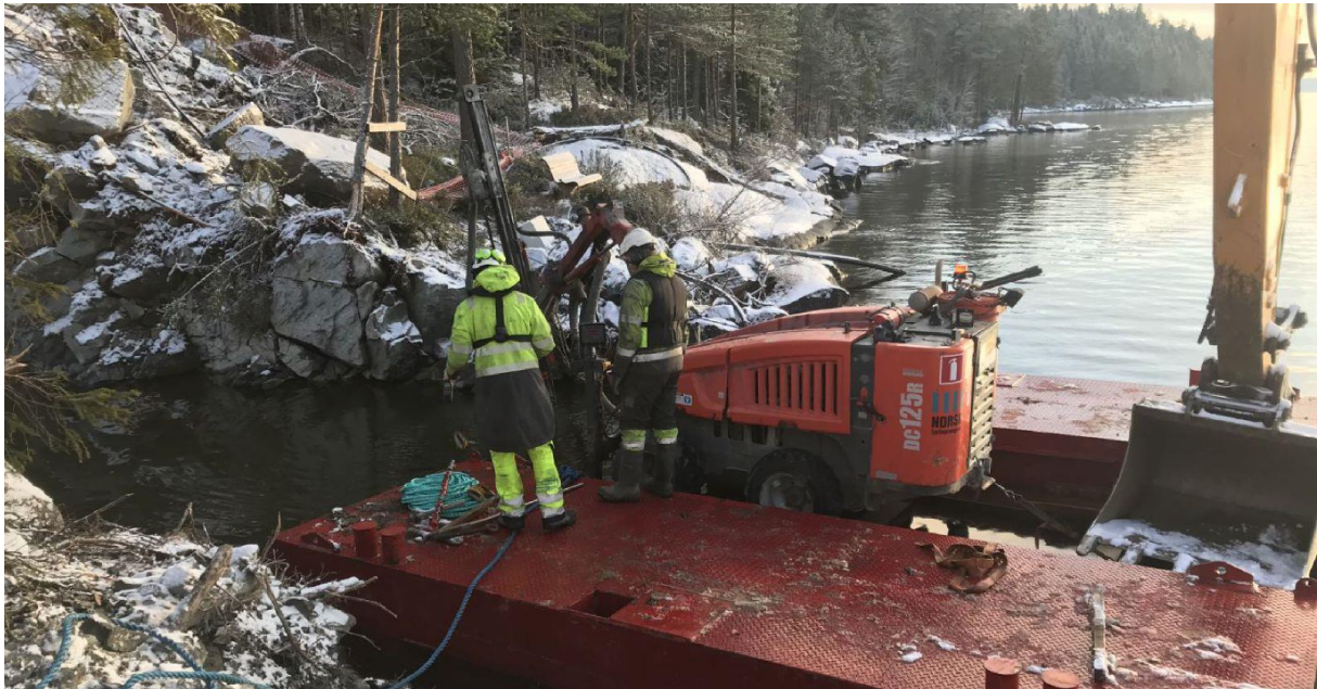
Eksempel på Commando borerigg om bord på lekter
