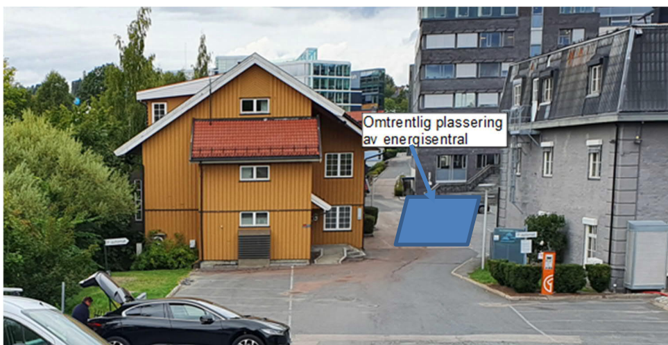
Figur 34 Område ved antatt plassering til energisentralen, utsnitt fra AF Anlegg's bilde 142110 fra 2020
