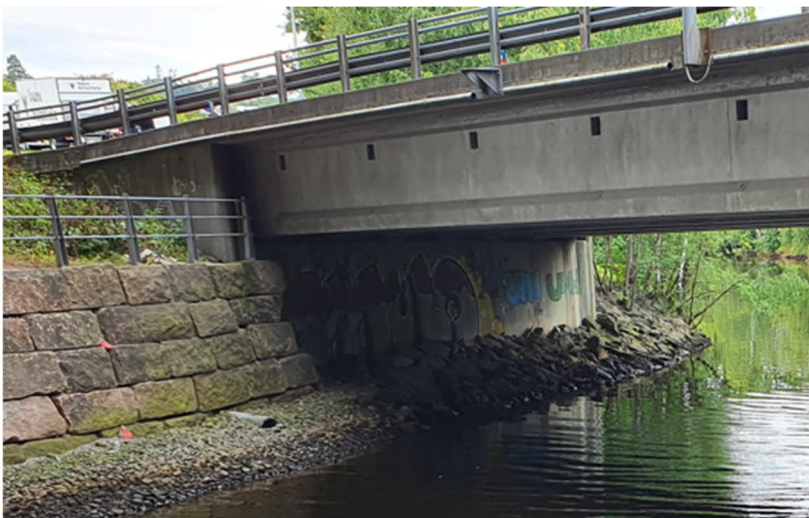
Figur 10 Vestre landkar til øverste veibru, utsnitt fra AF Anlegg's bilde 141834 fra 2020
