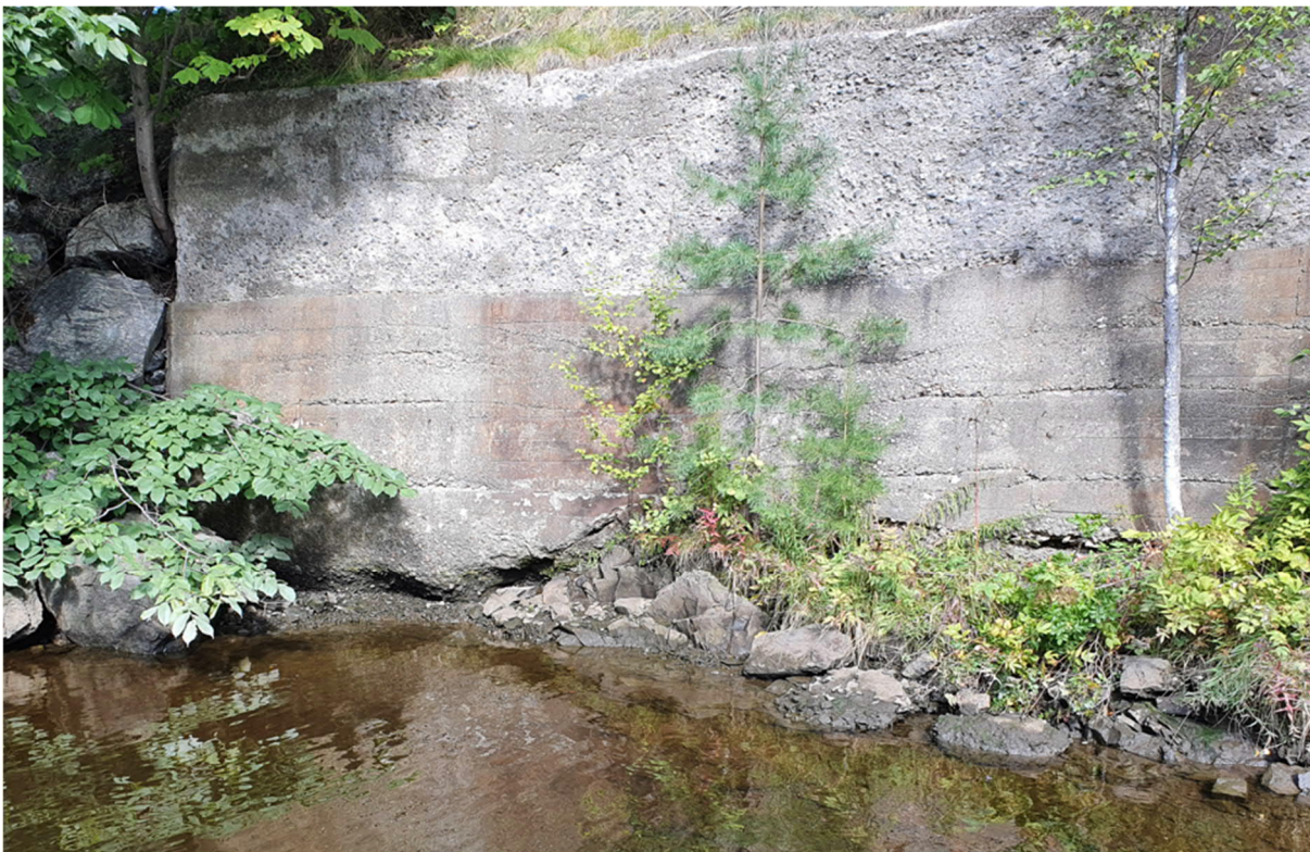
Figur 26 Støttemur langs nordøstre elvebredd opp mot trebrygge, utsnitt fra AF Anlegg's bilde 131159 fra 2020
