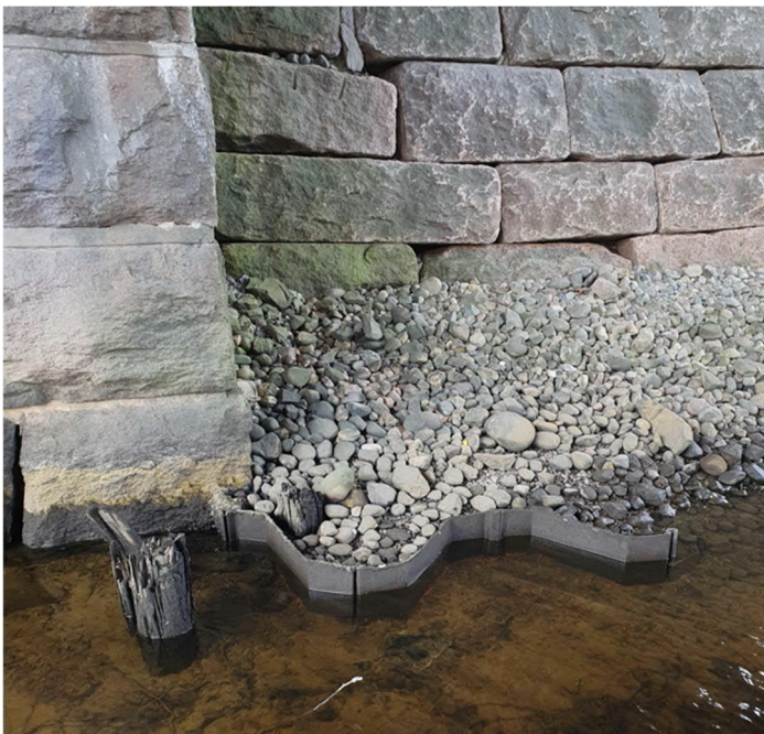
Figur 29 Spunt ved støttemur oppstrøms vestre jernbanebru, utsnitt fra AF Anlegg's bilde 130546 fra 2020
