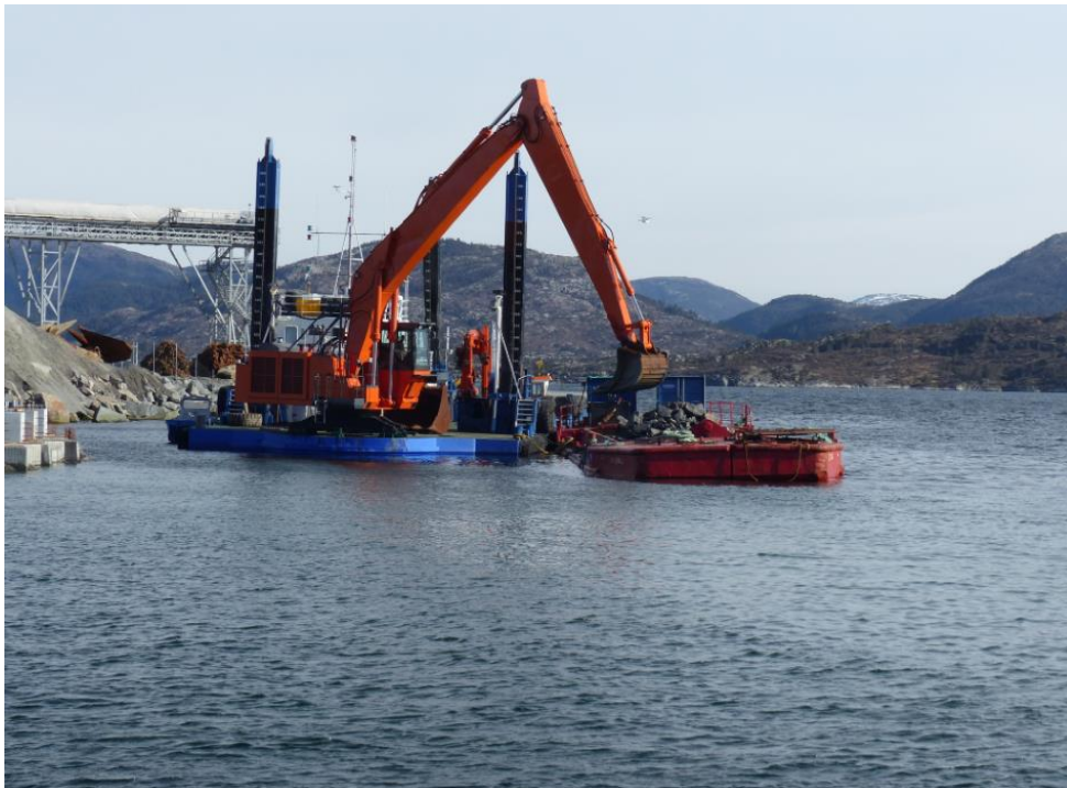
Mudringslekter 30x13 meter, mudringsdybde 17 meter
