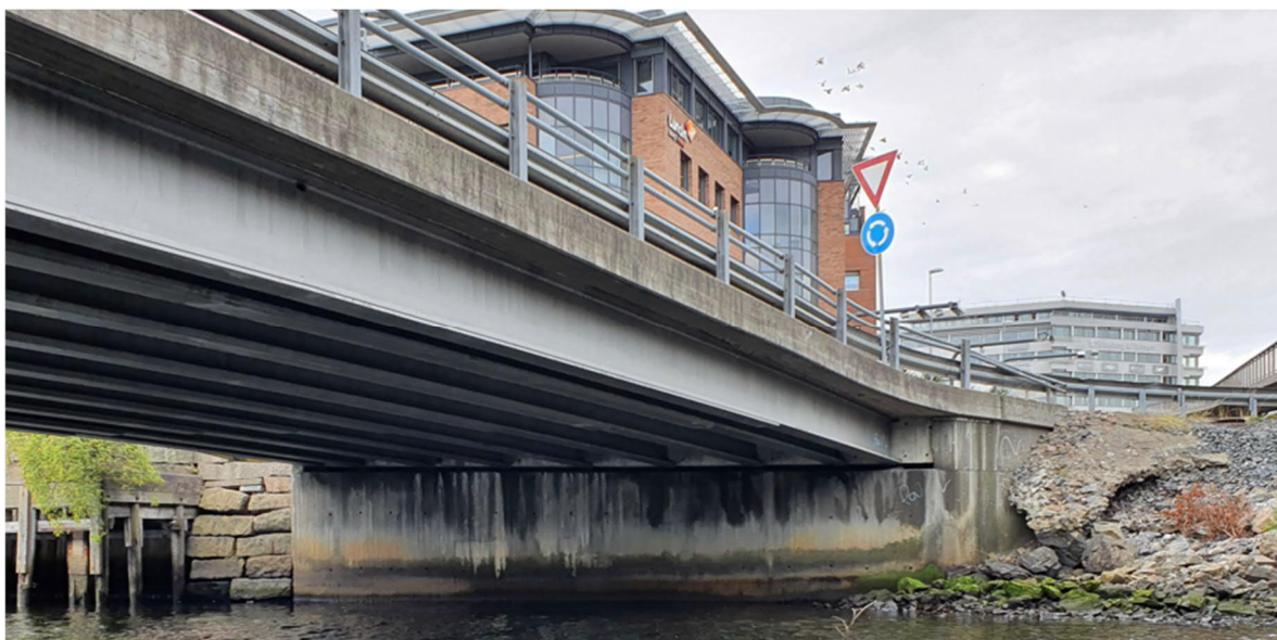
Figur 24 Vestre landkar til nederste lokalveibru, utsnitt fra AF Anlegg's bilde 141254 fra 2020
