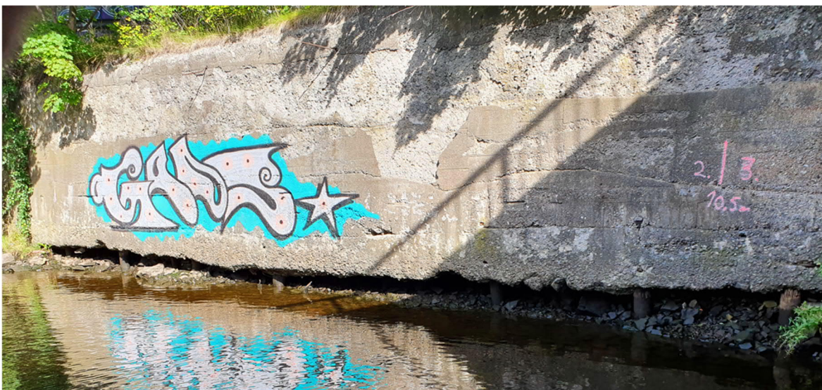
Figur 27 Støttemur langs nordøstre elvebredd ovenfor øverste veibru, utsnitt fra AF Anlegg's bilde 131023 fra 2020
