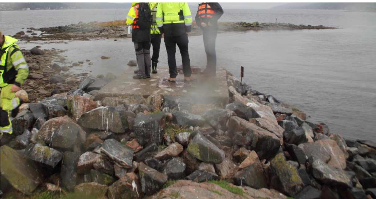
Figur 4.3: Bilde av eksisterende kum fra befaring som viser kum omringet av pukkestein fra utsprenging
