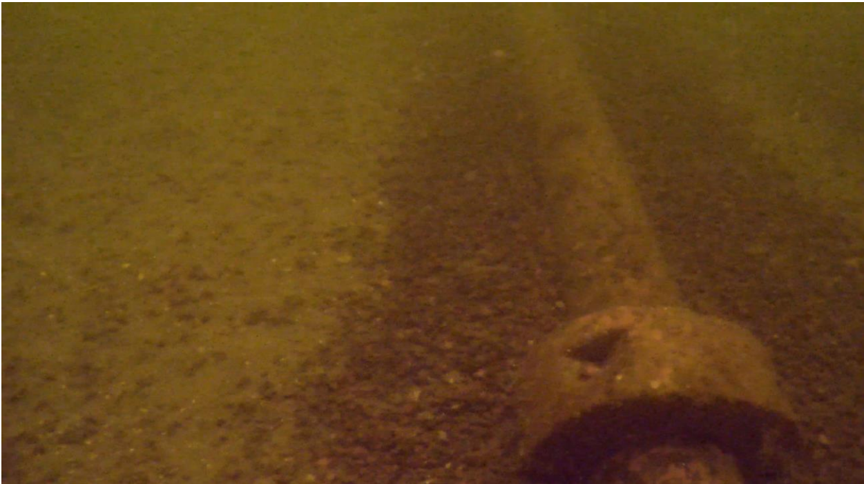
Figur V.7: Bilde tatt med ROV som viser eksisterende sjøledning delvis dekket med grus.
