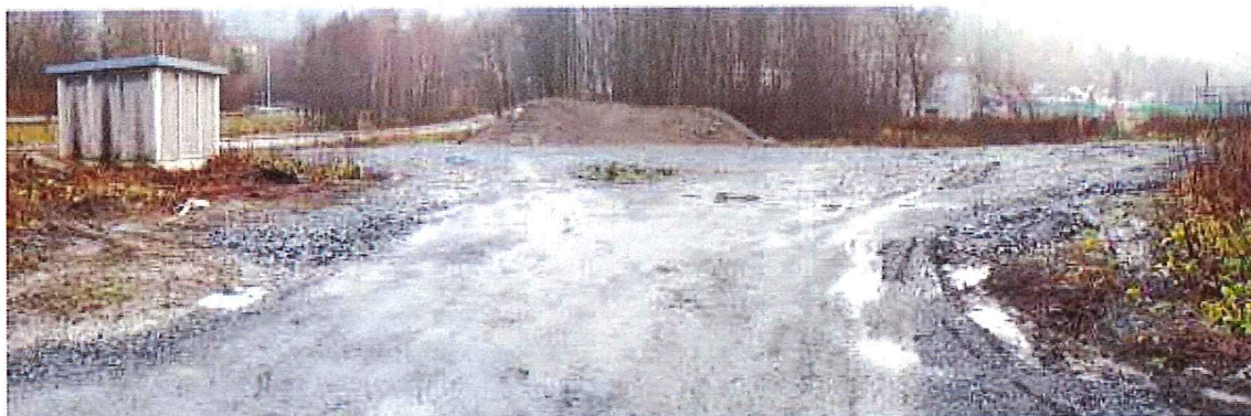
Figur 2-4: Oppfylte masser med grus og pukk på tomta.
